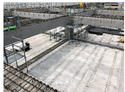
写真-2 施工状況
