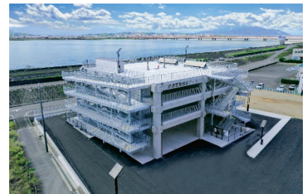
写真-1 全景写真（空撮）
