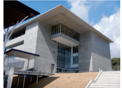
写真-1 建物外観
