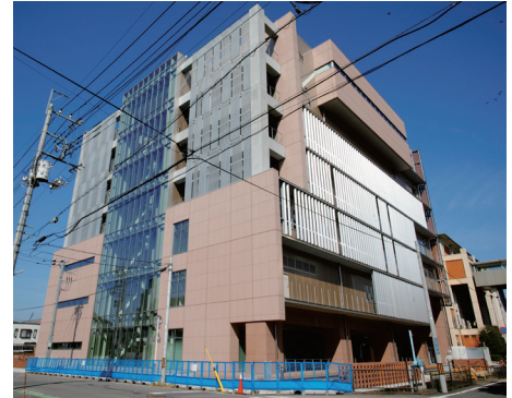
写真-1 建物外観
