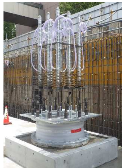
写真-3 仮設置状況
