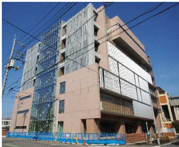
写真-1 建物外観
