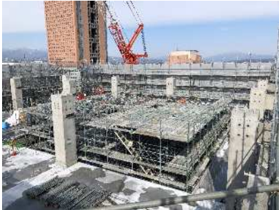
写真-16 支保工状況
