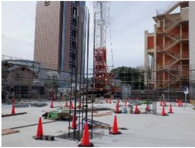
写真-4 PC 鋼棒の先立て状況
