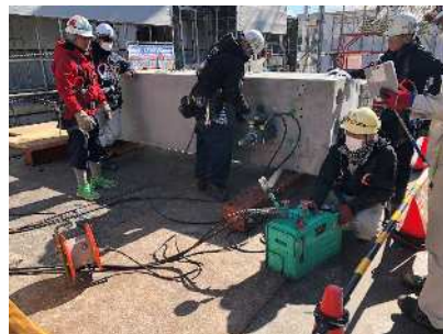
写真-14 PC 鋼棒緊張状況
