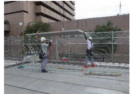
写真-9 カイザー板架設状況
