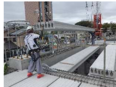
写真-8 スパンクリート架設状況
