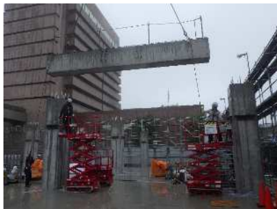
写真-7 梁架設状況
