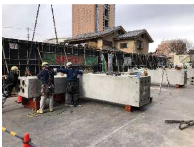
写真-13 キャンチ梁付き柱 仮置き状況
