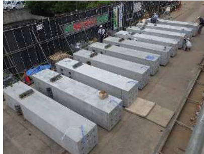
写真-5 柱仮置き状況
