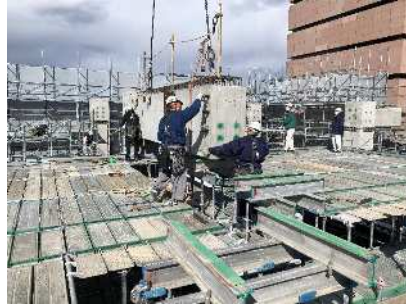
写真-17 分割梁架設状況
