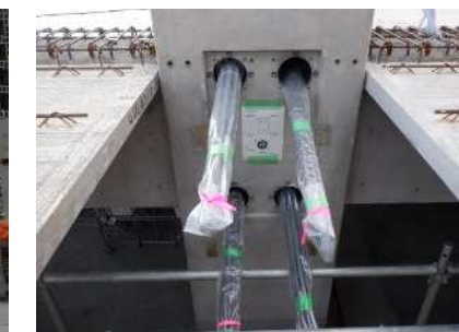
写真-12 PC ケーブル見える化
