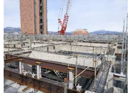
写真-18 十字格子梁緊張完了
