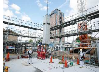
写真-6 柱架設状況
