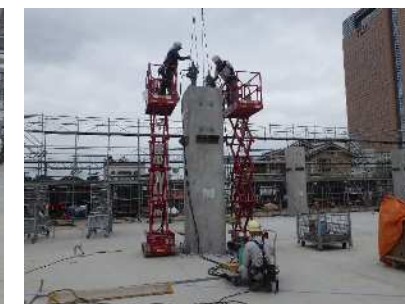
写真-11 PC 鋼棒緊張状況
