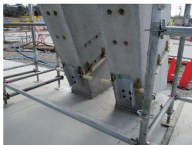
写真-3 柱脚部固定用治具
