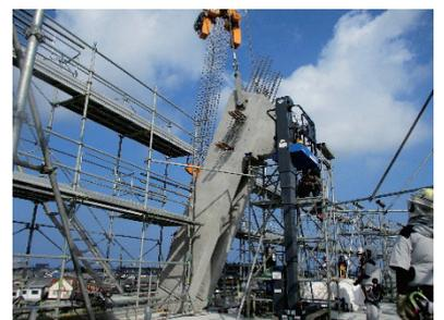
写真-2 斜め柱架設状況
