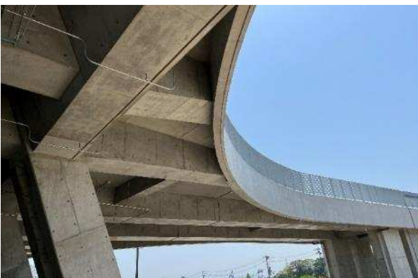
写真-4 サイドスタンドPC梁 (連絡通路)
