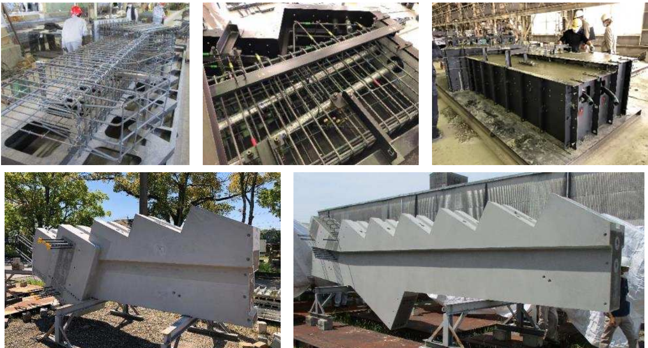
写真-6 段梁製作状況
