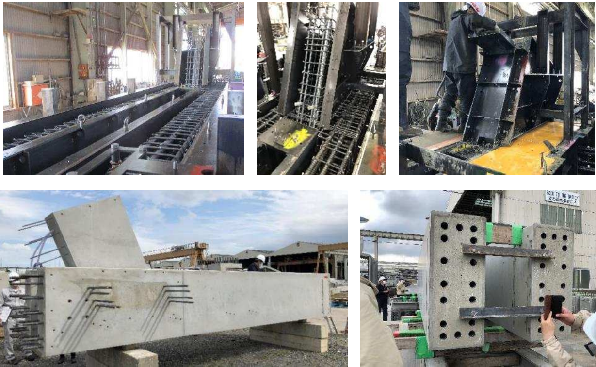
写真-5 斜め柱製作状況
