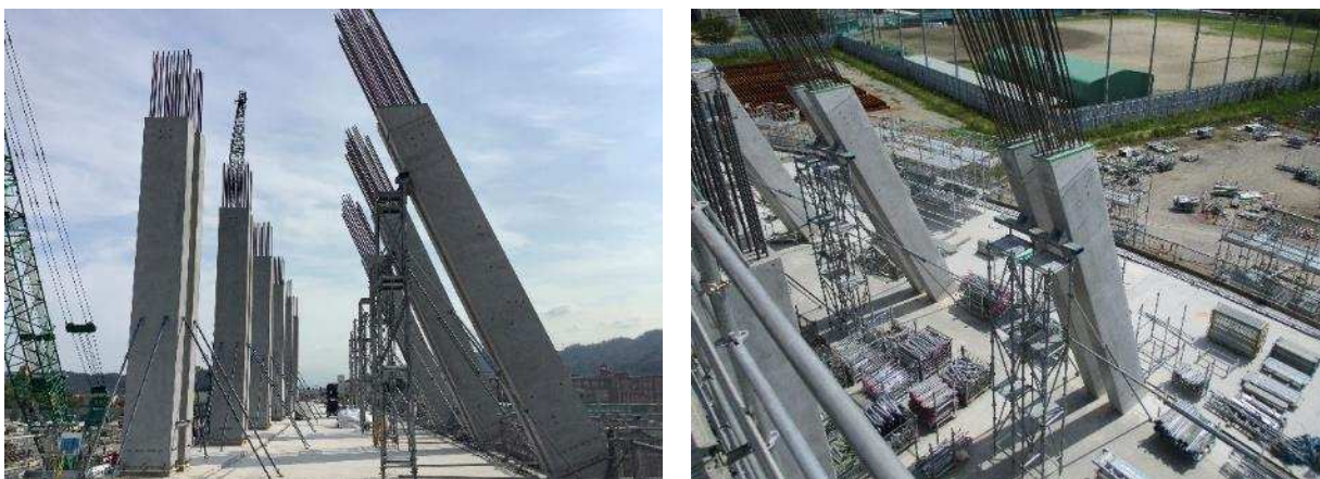
写真-10 バックスタンド斜め柱施工状況
