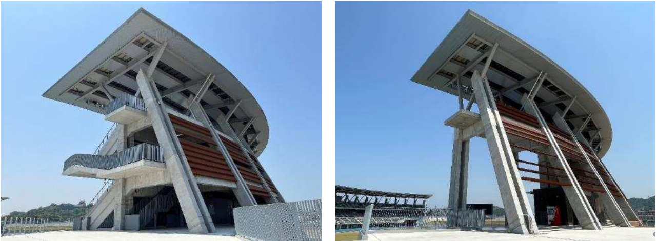
写真-2 建物外観 (左:メインスタンド, 右:バックスタンド)
