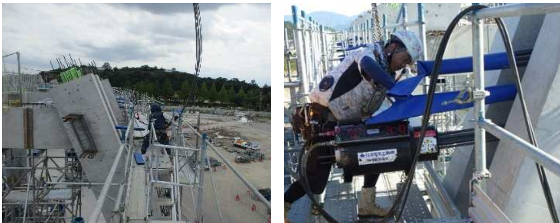
写真-12 緊張作業状況
