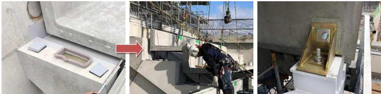
写真-14 PC段床版の固定状況 (左・中央：段梁取合い、右：鉄骨小梁取合い)
