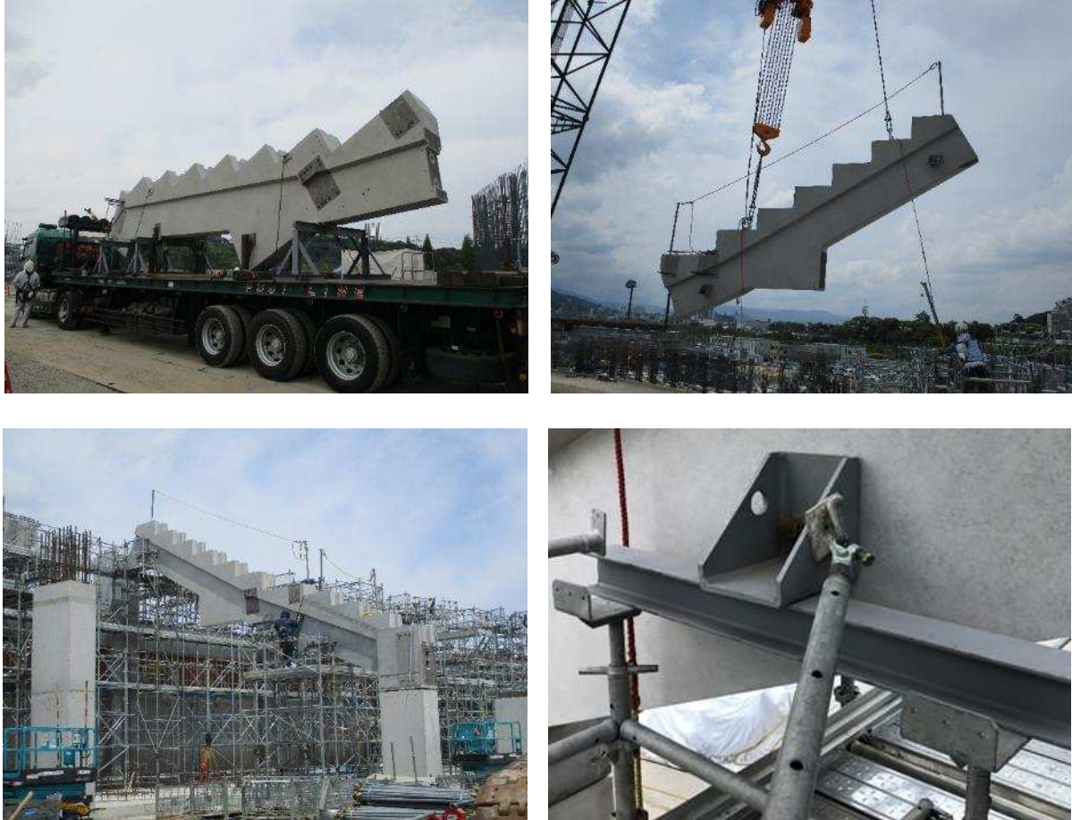
写真-11 段梁の架設状況
