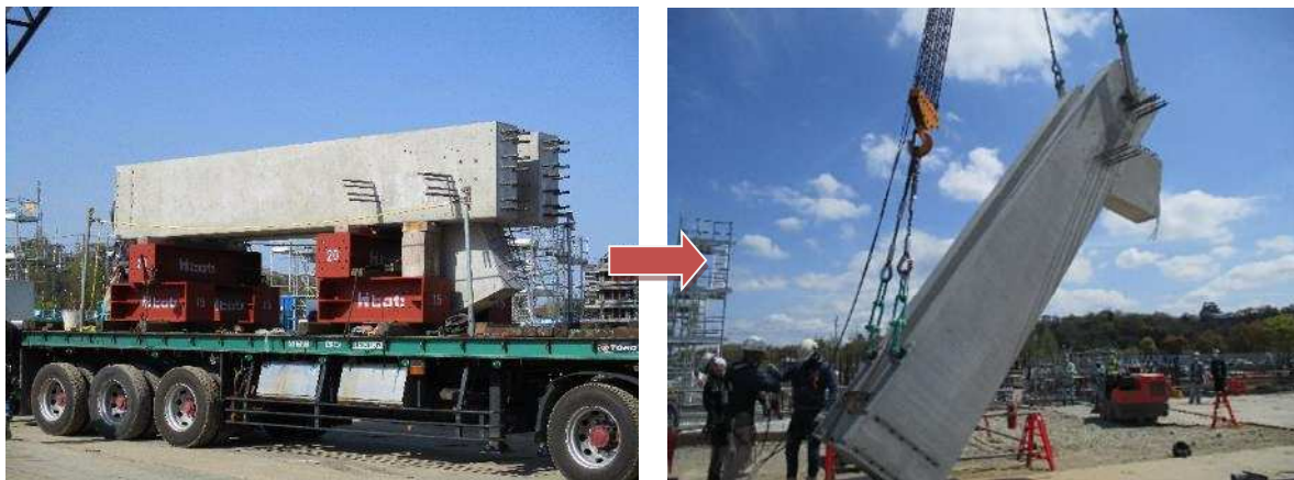
写真-8 建て起こし吊姿
