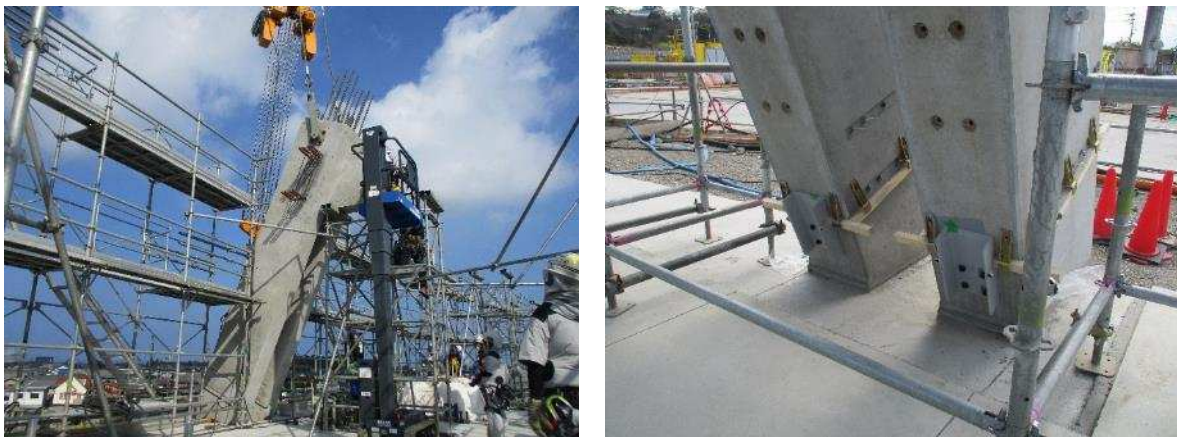
写真-9 メインスタンド斜め柱架設状況
