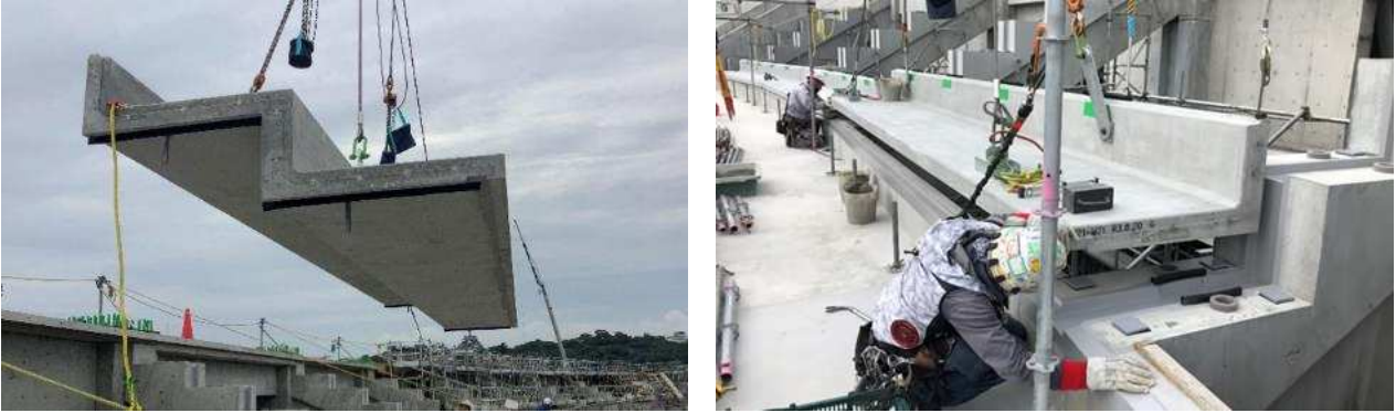
写真-13 PC 段床版架設状況
