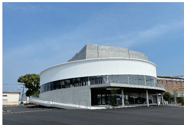
写真-1 建物外観
