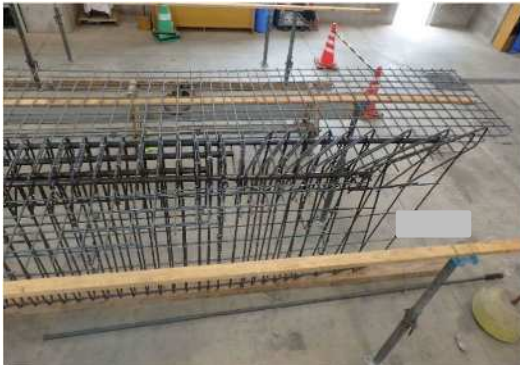
写真-8 配筋状況
