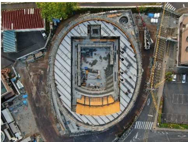
写真-13 ドローン空撮
