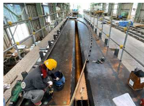
写真-7 型枠仮組状況
