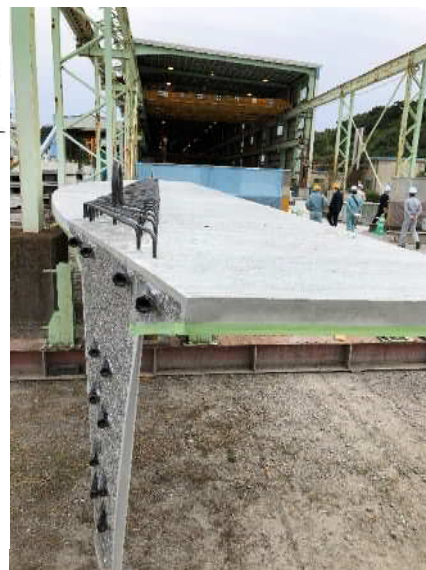
写真-4 ST 合成床版の一例
