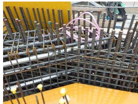
写真-17 固定端施工状況
