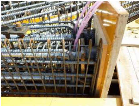
写真-16 緊張端施工状況
