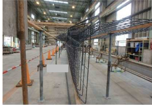
写真-9 配筋状況
