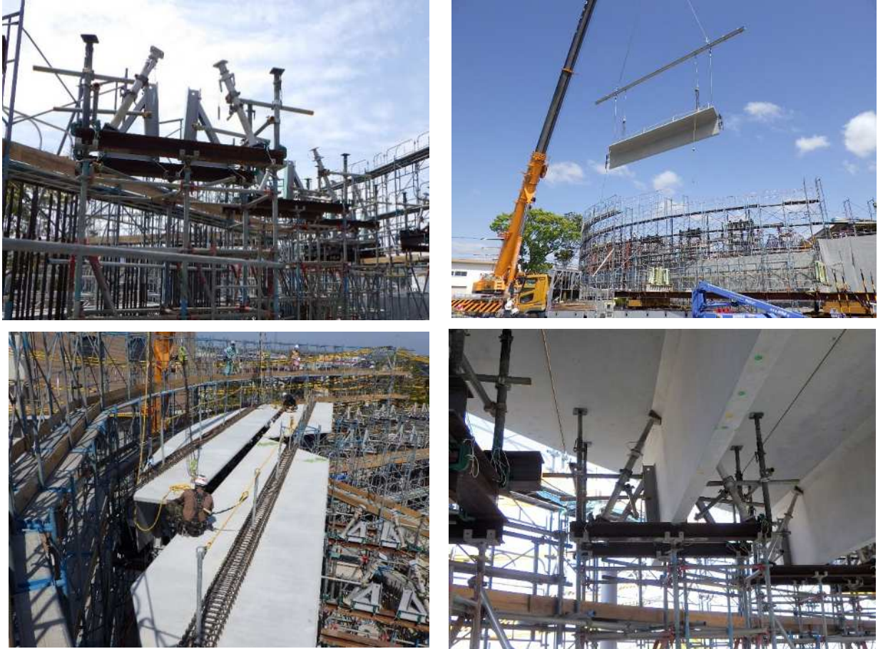
写真-12 部材架設状況
