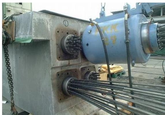
写真-5 実物大 PC 桁の緊張状況
