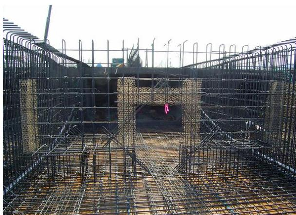
写真-3 アラミド繊維補強(断面欠損部)
