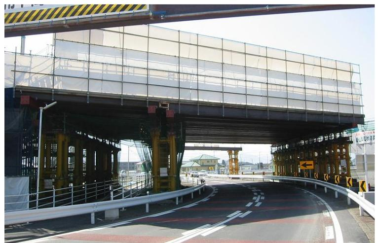
写真-8 支柱式支保工(3次施工)300t 耐力ベント
