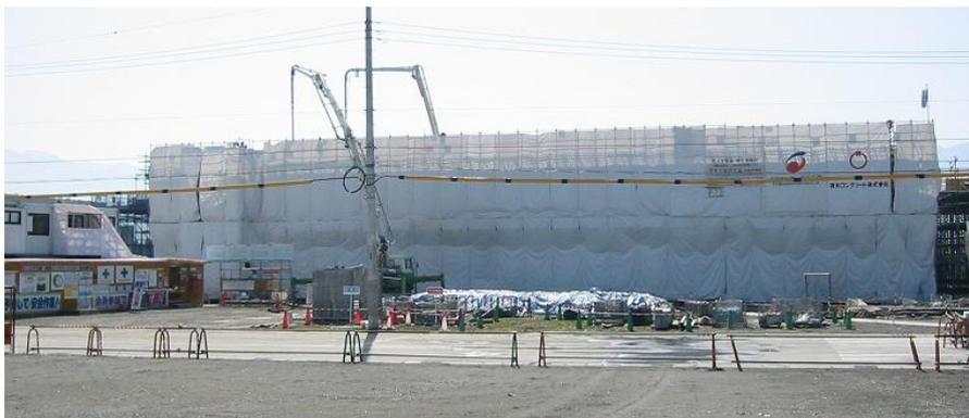
写真-1 主桁製作1次施工 打設状況全景(冬季のためシート養生)
