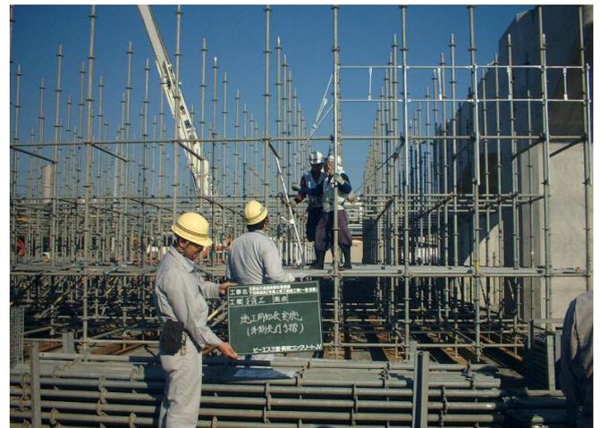
写真-7 枠組支保工組立状況
