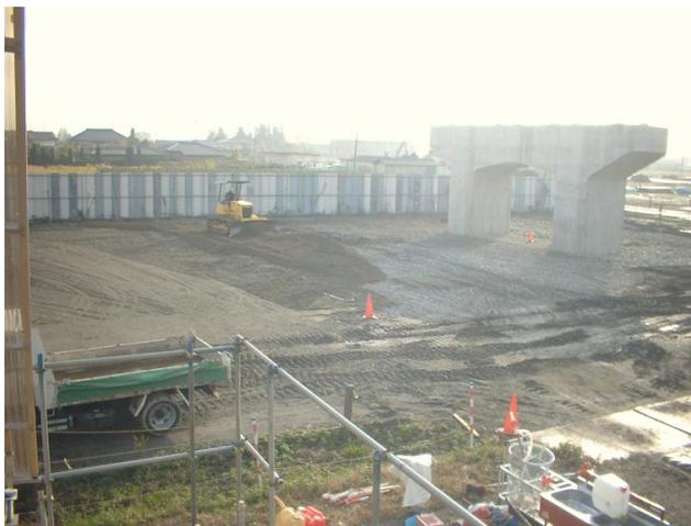
写真-6 支保工基礎施工状況
