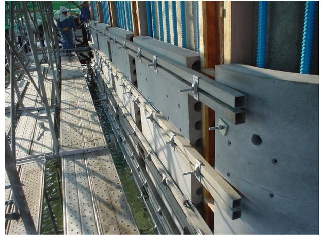
写真-4 一次コンクリート型枠組立状況
