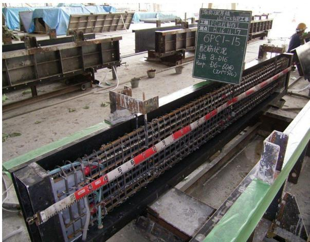
写真-5 PCa柱配筋状況
