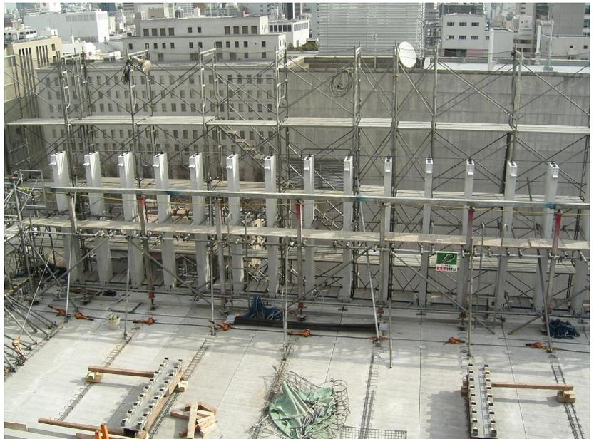
写真-10 PCa 柱建方完了状況
