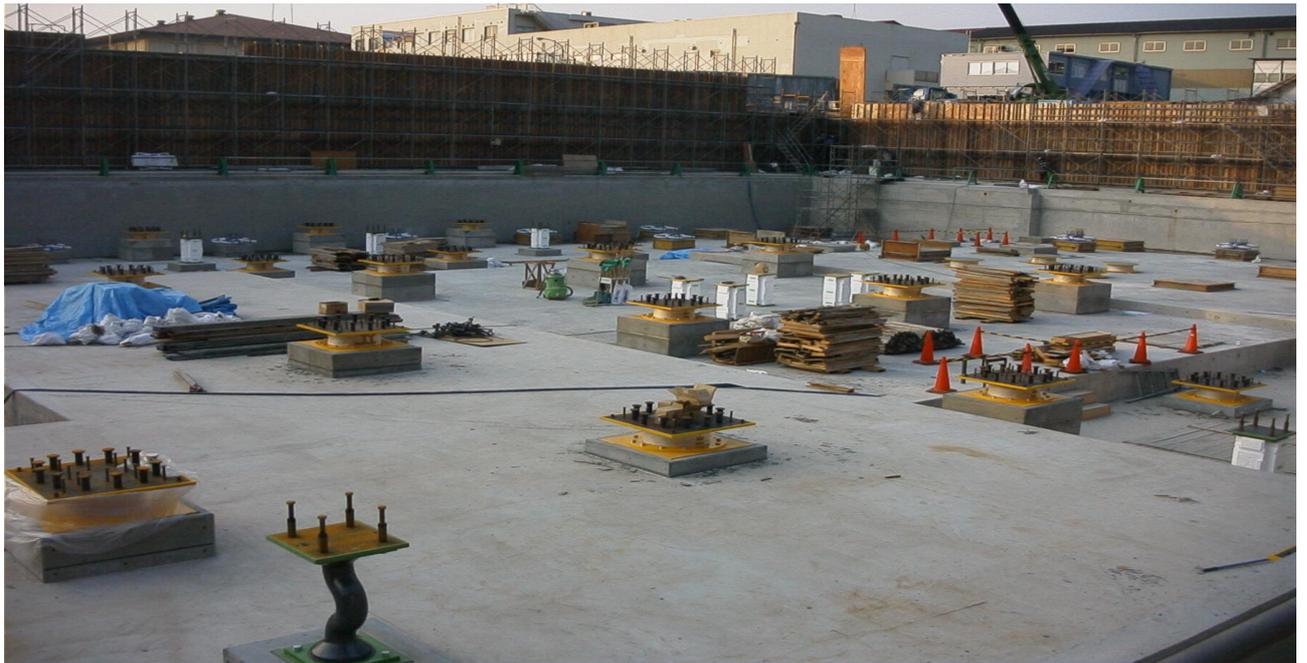
写真-2 免震装置取り付け全景
