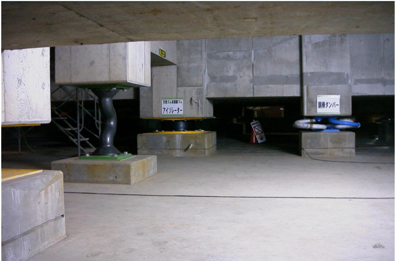
写真-8 免震装置状況(躯体工事完了時)
