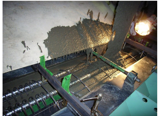
写真-7 打設状況
