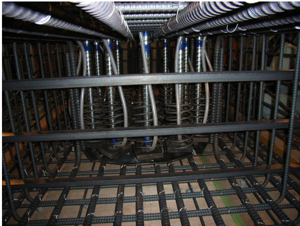
写真-12 PC 鋼棒アンカー
