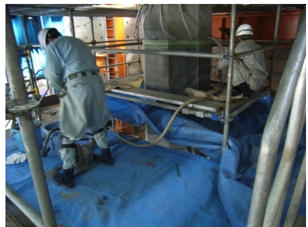
写真-17 グラウト状況
