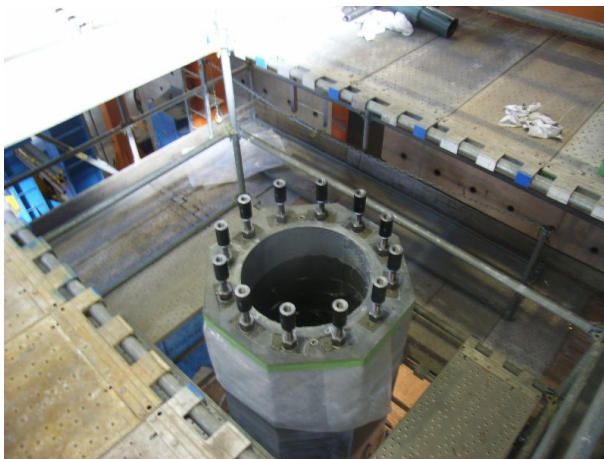
写真-18 旧セグメント天端
