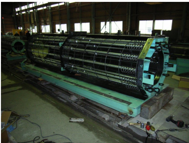
写真-4 鉄筋組立・シース配置状況
