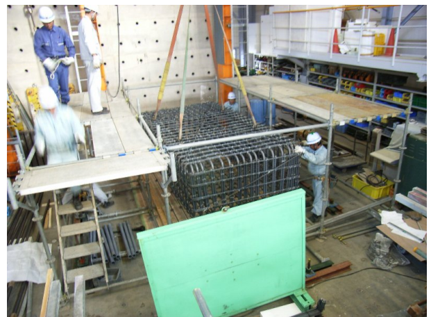
写真-11 鉄筋組立
