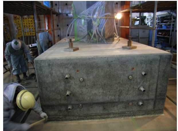
写真-15 フーチング出来形
