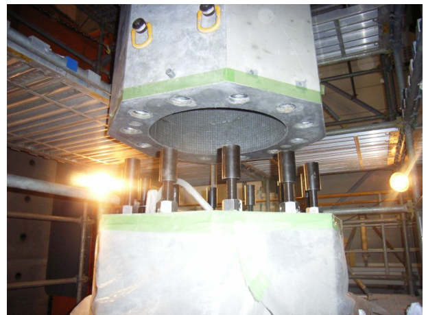
写真-19 新セグメント設置
