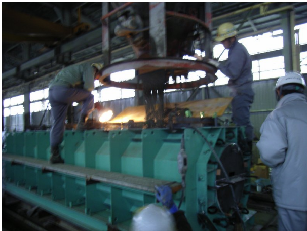
写真-6 打設状況
