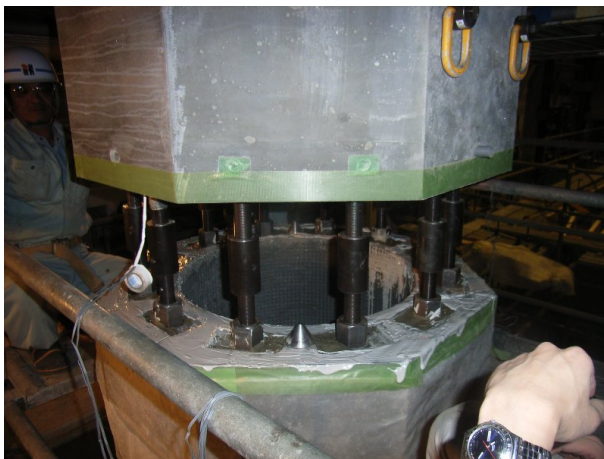
写真-20 PC鋼棒のカプリング
