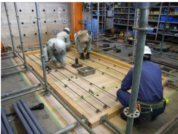
写真-10 底板組立
