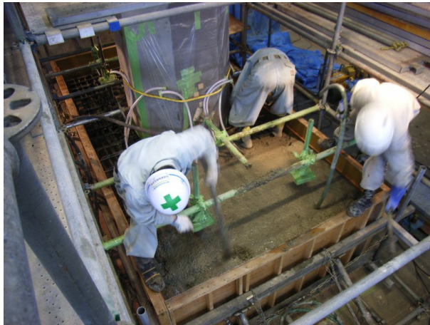
写真-14 フーチング打設状況
