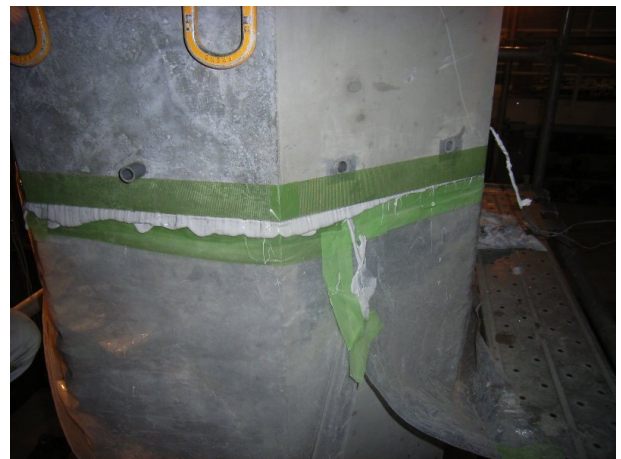
写真-21 新セグメント設置
