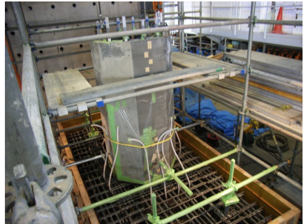
写真-13 基部セグメント設置
