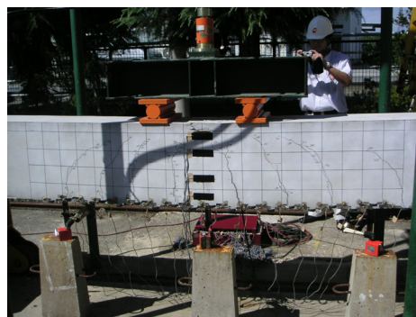
写真-13 ひび割れ状況 (エポキシ)
