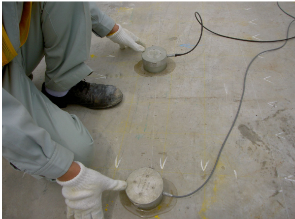
写真-25 超音波探傷試験状況
