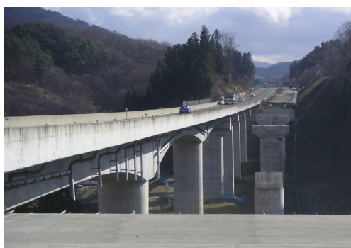
写真-1 施工前全景(A1側より)
