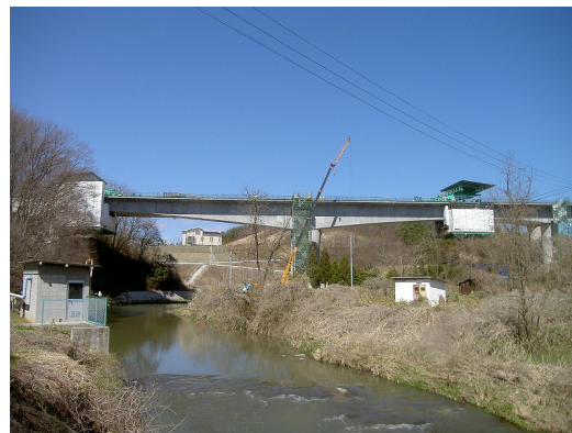
写真-28 現状(下流側より)
