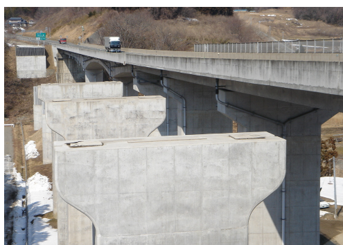
写真-2 施工前全景(A2側より)
