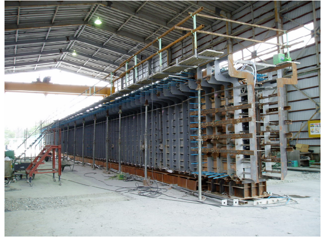
写真-21 型枠組立
