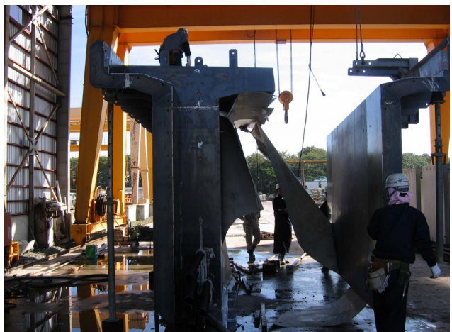
写真-14 シート貼り付け (クラザップシート)
