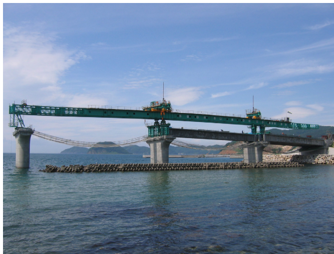
写真-32 施工進捗状況
