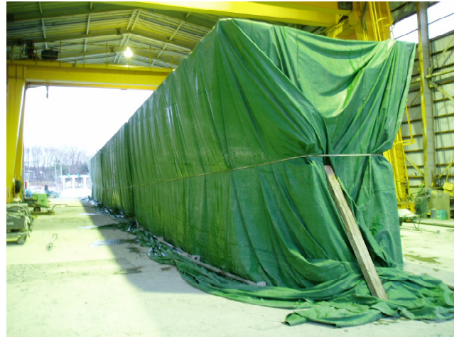
写真-23 蒸気養生
