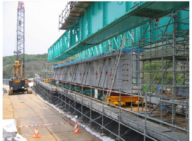
写真-27 架設桁据付完了
