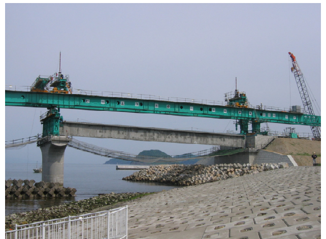
写真-31 主桁架設
