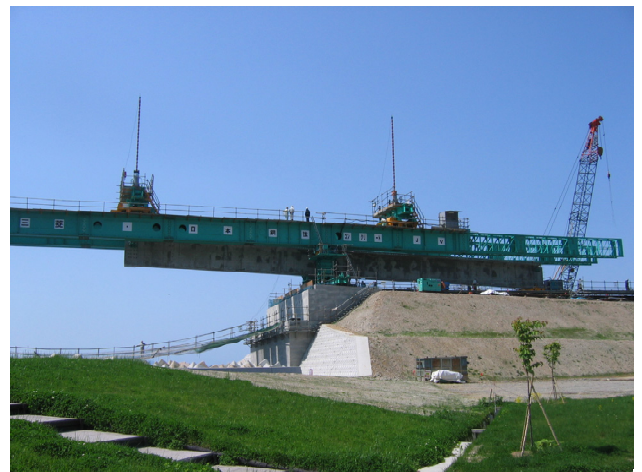
写真-29 主桁引き出し
