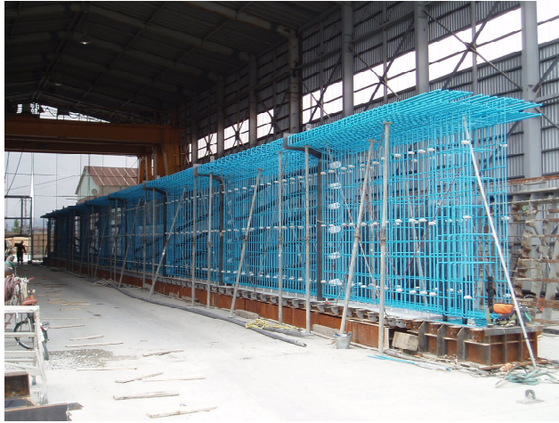
写真-20 鉄筋組組立
