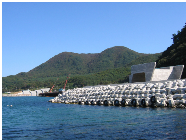
写真-1 施工前写真 (橋梁側面より撮影)
