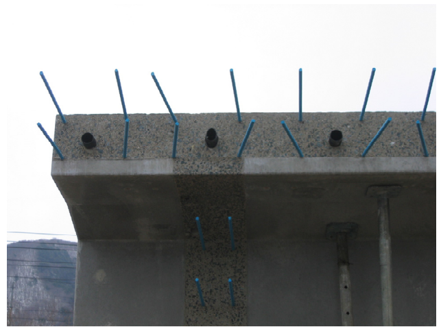
写真-5 粗面仕上げ状況(2)
