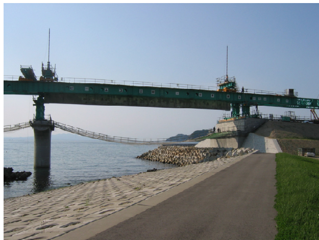
写真-30 主桁吊り上げ
