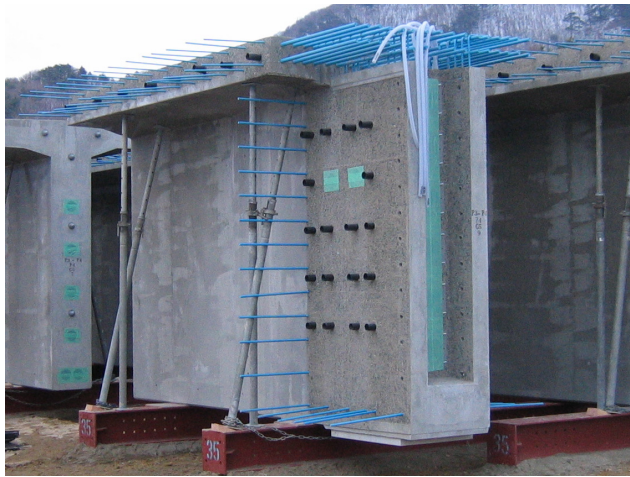
写真-4 粗面仕上げ状況(1)
