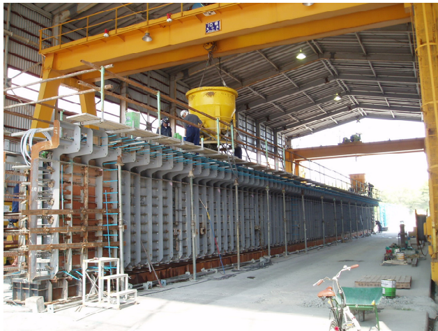
写真-22 コンクリート打設
