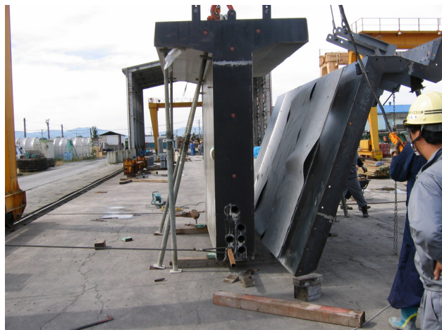
写真-15 シート貼り付け (エアエックス)
