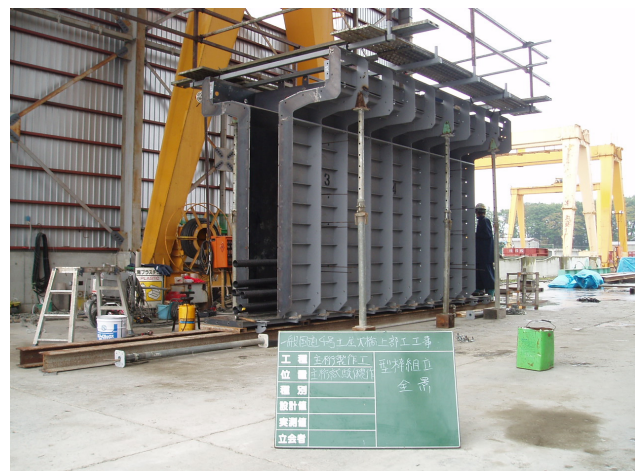
写真-13 型枠組立完了
