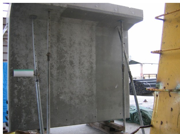
写真-17 脱枠完了 (エアエックス)
