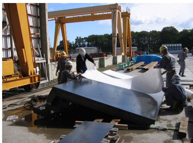
写真-12 透水シート貼り付け
