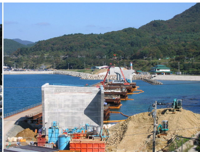
写真-2 施工前写真 (A2橋台背面より撮影)
