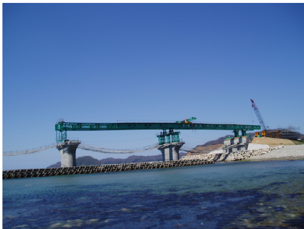
写真-28 主桁組立
