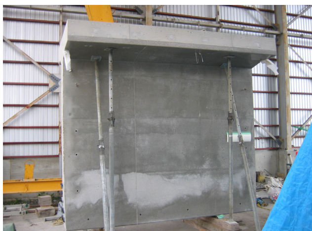
写真-16 脱枠完了 (クラザップシート)
