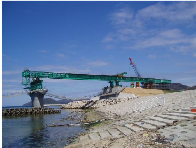
写真-26 架設桁組立
