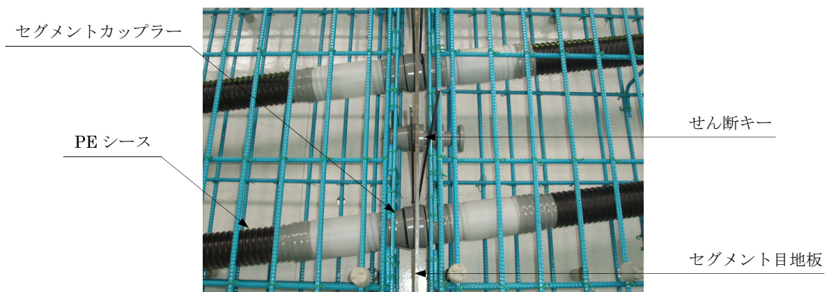
写真-3 セグメントカップラーシース設置状況
