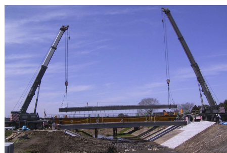
写真-3 主桁架設状況
