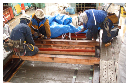
写真-2 伏せ型枠設置状況
