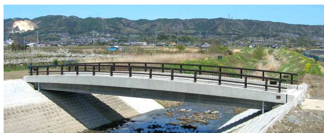
写真-4 完成状況
