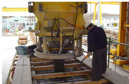
写真-1 打設状況
