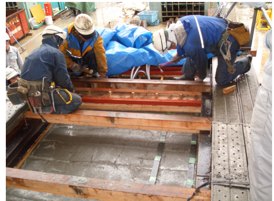
写真-5 伏せ型枠設置状況
