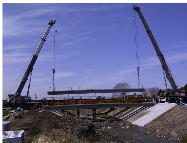
写真-8 主桁架設状況
