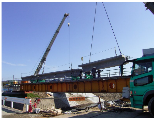
写真-6 セグメント設置状況
