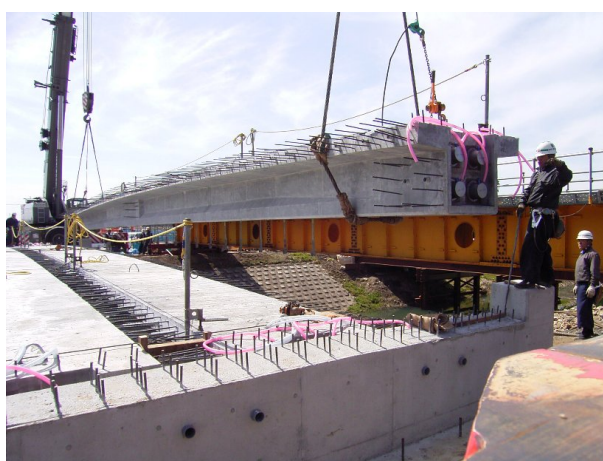
写真-8 主桁架設状況
