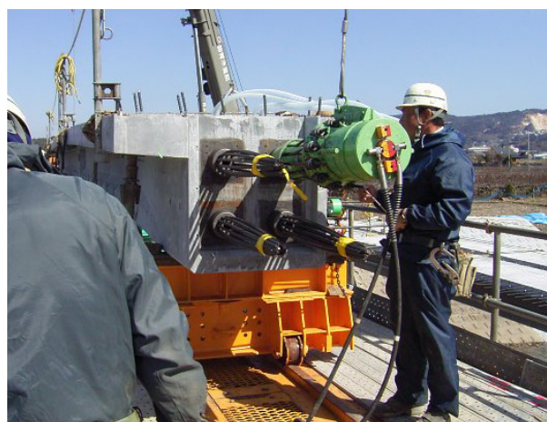
写真-7 主ケーブル緊張状況
