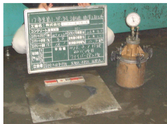
写真-3 品質管理試験状況
