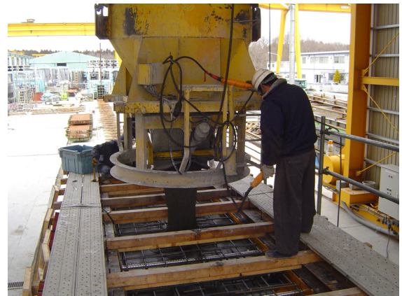
写真-4 打設状況
