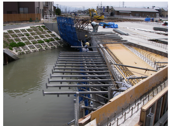
写真-3 床版支保工組み立て状況
