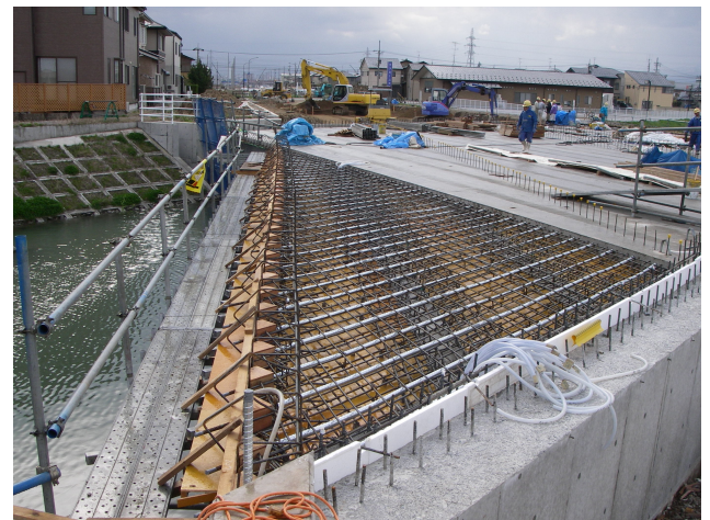
写真-4 床版コンクリート打設前
