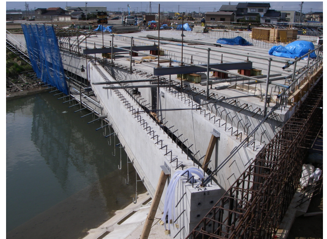
写真-2 枝桁架設直後
