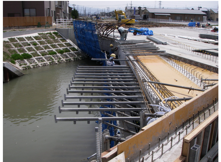
写真-4 床版支保工組み立て状況
