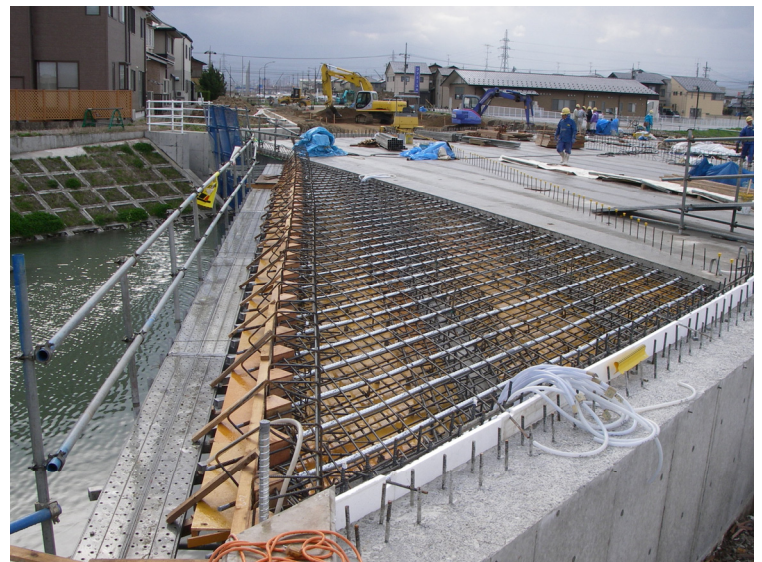
写真-5 床版コンクリート打設前
