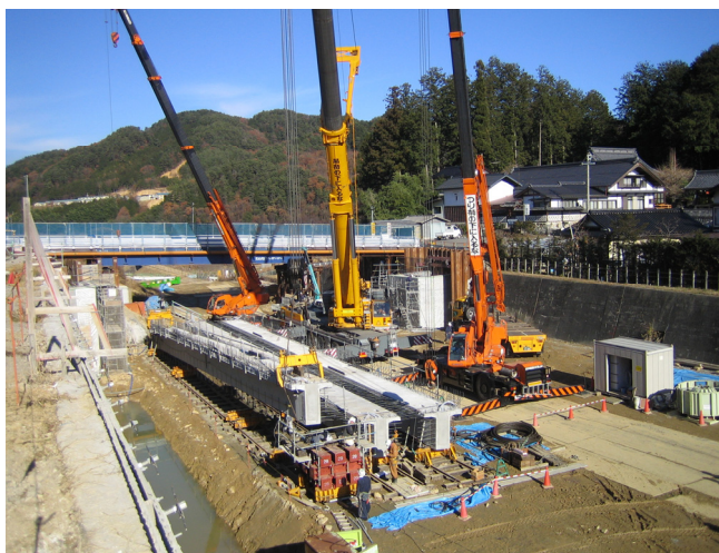
写真-1 主桁架設状況
