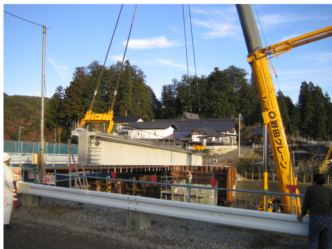
写真-2 主桁架設状況
