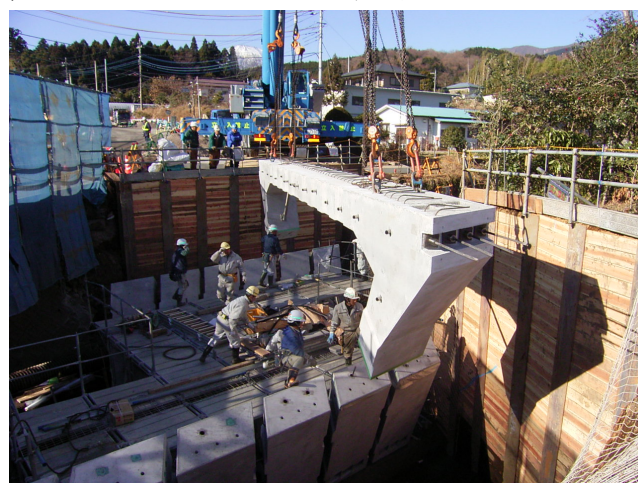
写真-2 架設状況
