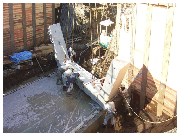
写真-5 下ブロック架設
