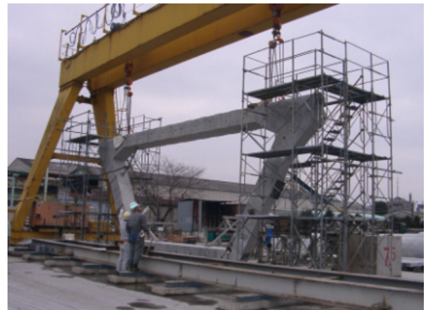
写真-2 仮組状況
