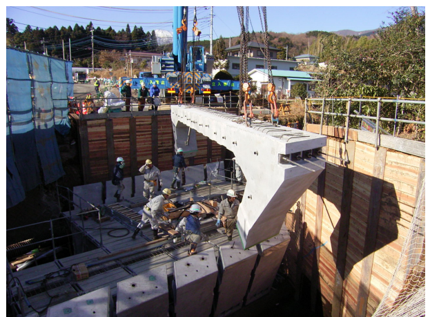
写真-6 上ブロック架設
