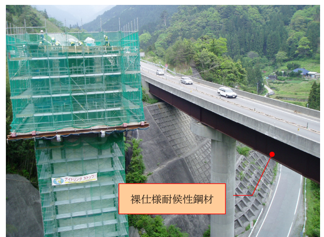
写真-1 隣接供用線
