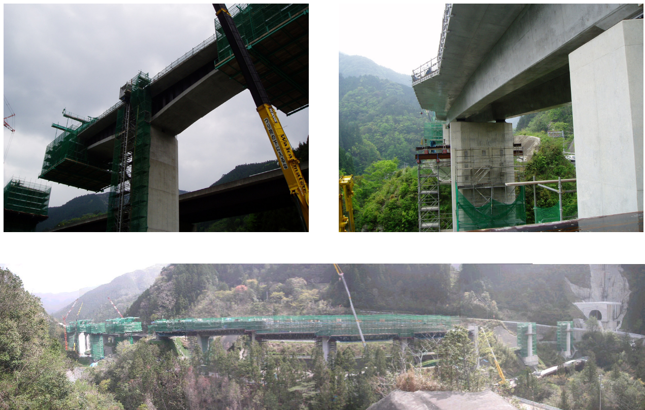
写真-7 現場状況
