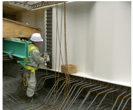
写真-2 高力ボルト接合状況
