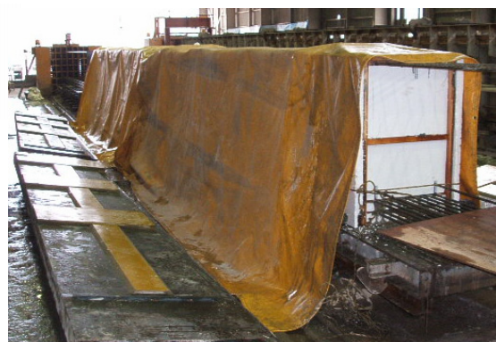
写真-1 養生状況
