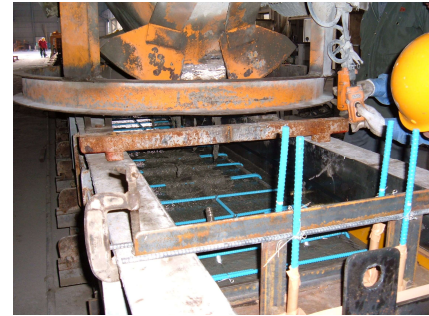
写真-1 打設状況
