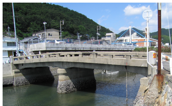
写真-1 旧橋全景
