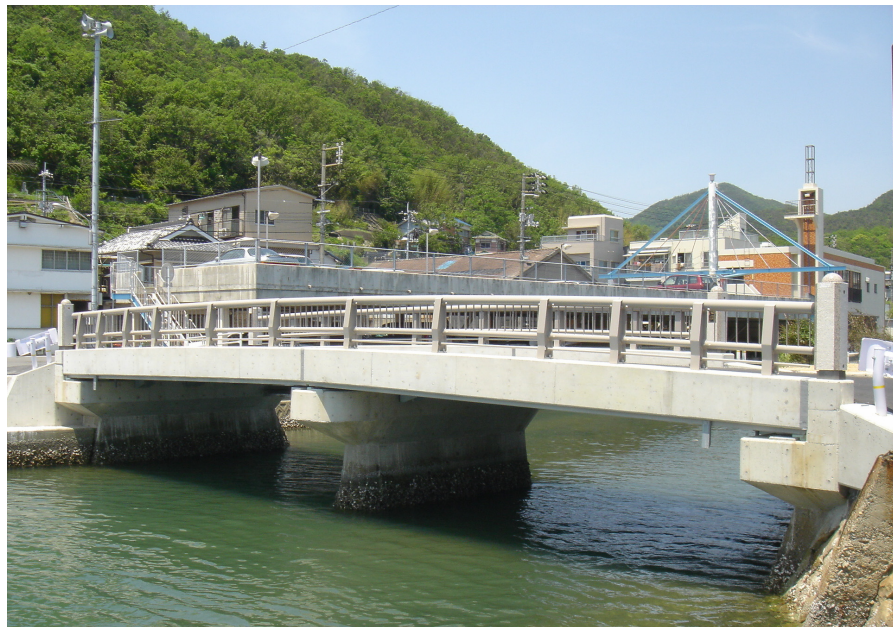
写真－6 完成状況
