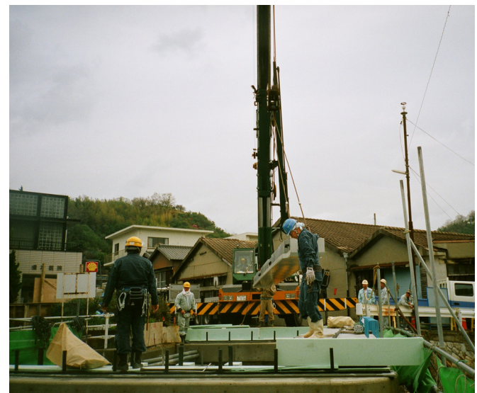
写真-5 主桁架設状況
