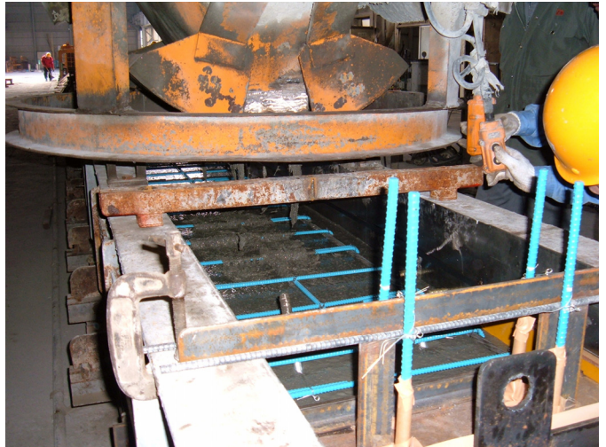
写真-3 打設状況
