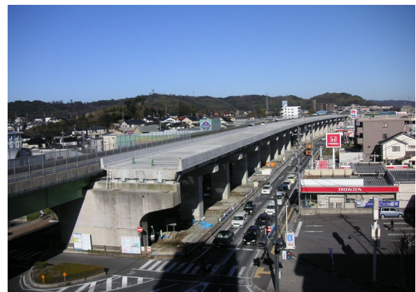
写真-1 橋梁全景
