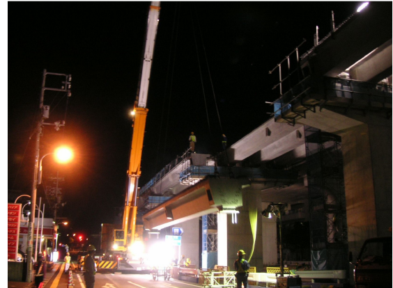
写真-2 主桁架設状況
