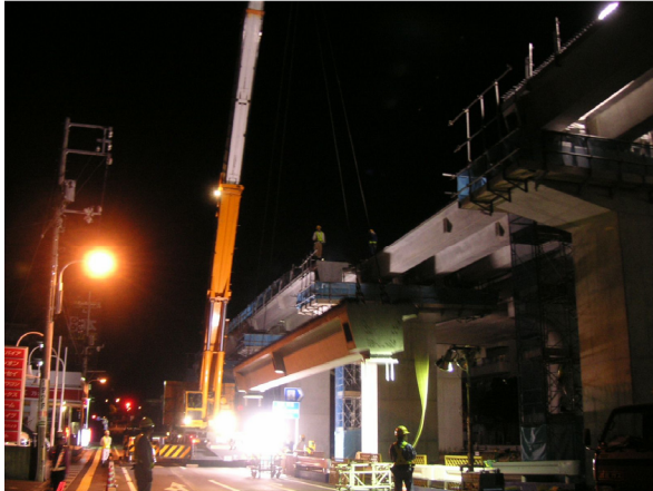
写真-5 主桁架設状況
