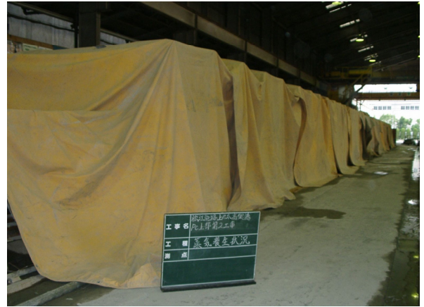
写真-2 蒸気養生状況
