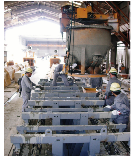
写真-4 コンクリート打設状況
