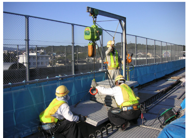
写真-6 PC板架設状況
