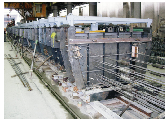
写真一1 型枠組立て状況
