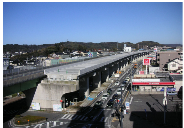
写真-7 橋梁全景
