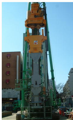
写真-2 施工機械
