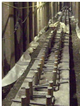
写真-6 完成状況
