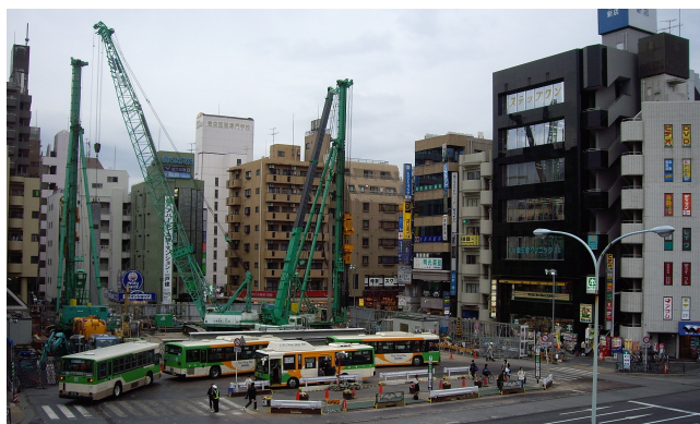
写真-1 東側施工状況
