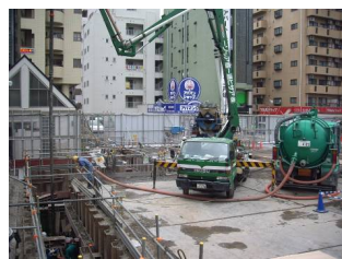
写真-4 コンクリート打設
