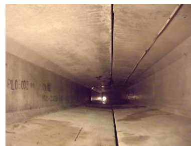
写真-21 掘削清掃完了
