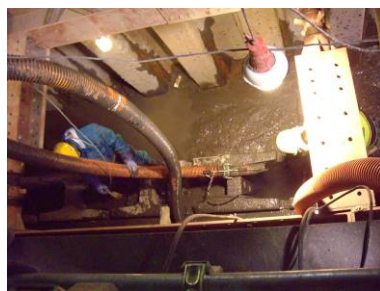
写真-20 バキュームを用いた掘削清掃状況
