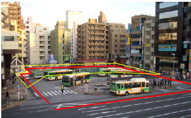
写真-1 東側施工前状況
