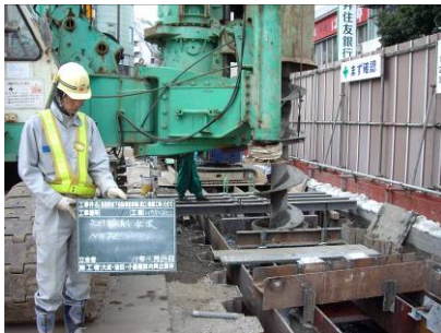
写真-25 プレボーリング
