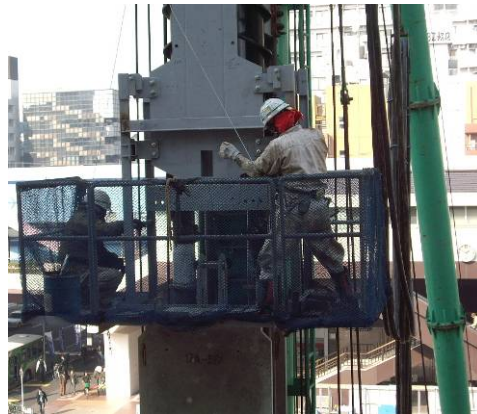
写真-11 オーガスクリュー接続
