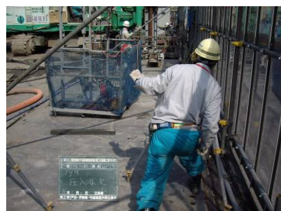
写真-17 打ち止め管理状況
