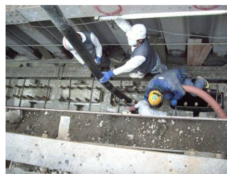
写真-23 間詰めコンクリート打設状況
