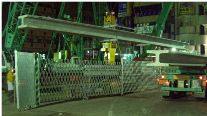
写真-5 杭搬入状況
