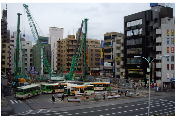
写真-3 東側施工状況
