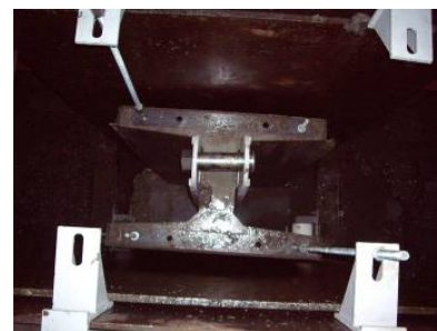
写真-19 沈下防止措置
