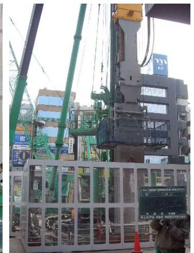
写真-16 圧入状況
