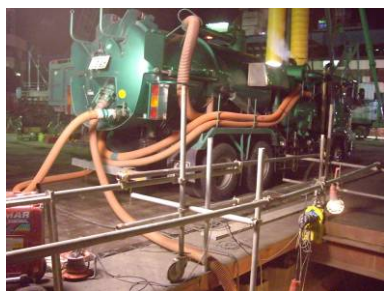
写真-20 バキュームを用いた掘削清掃状況
