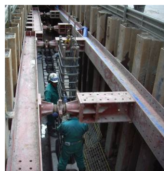
写真-22 鉄筋籠挿入状況
