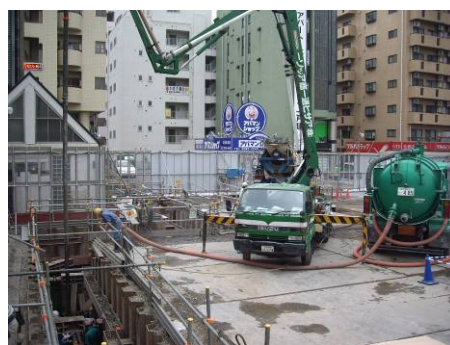
写真-23 間詰めコンクリート打設状況
