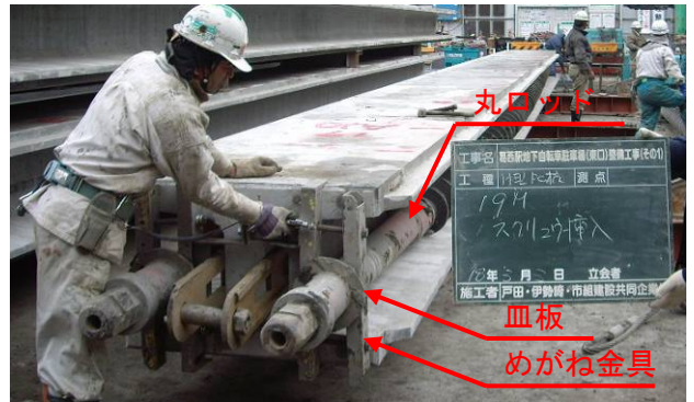
写真-6 スクリュー挿入状況
