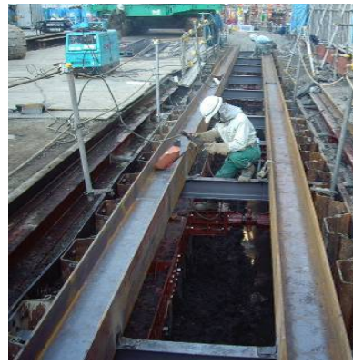
写真-4 導枠設置状況
