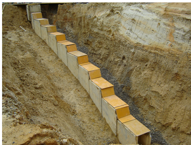
写真-4 傾斜部施工完了
