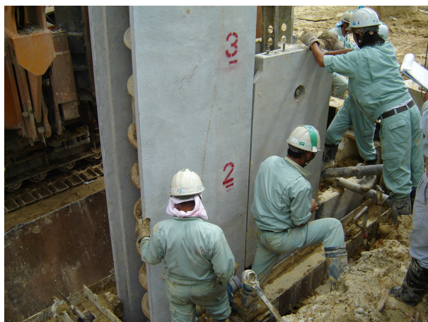
写真-3 コンクリートヤットコ使用状況
