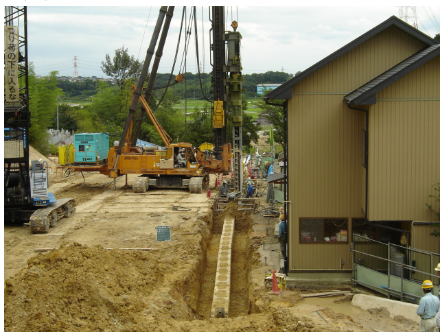
写真-2 杭打設状況
