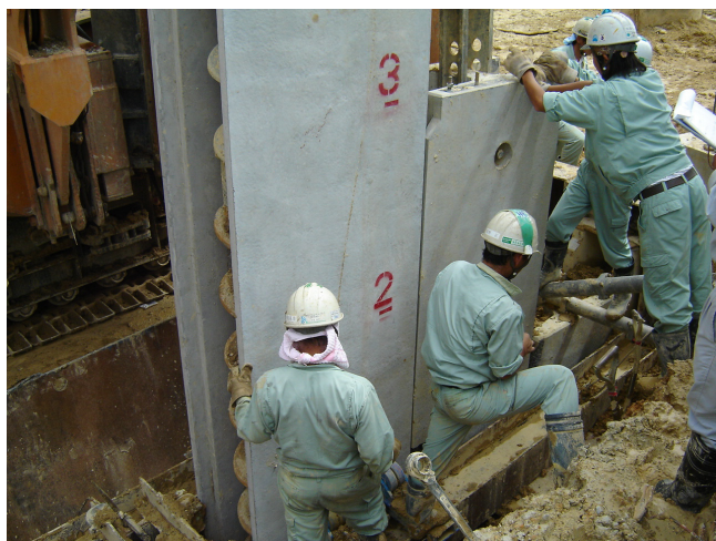
写真-4 コンクリートヤットコ使用状況
