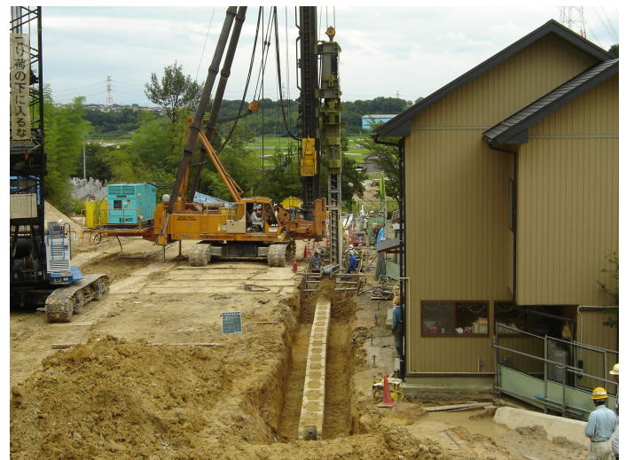
写真-3 杭打設状況
