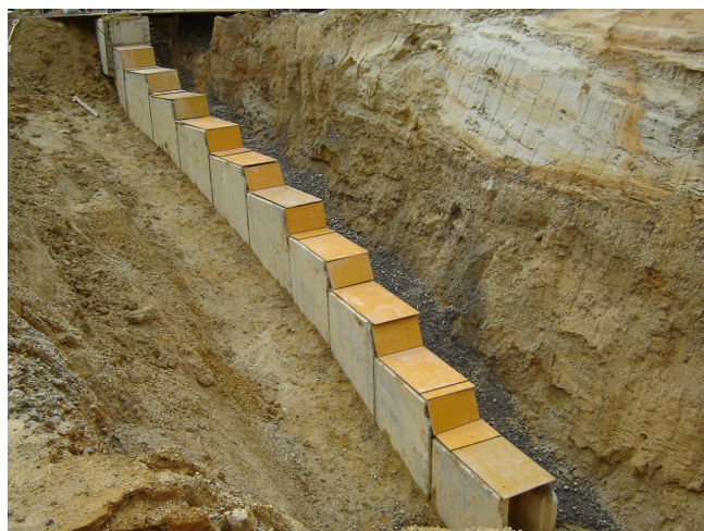
写真-5 傾斜部施工完了
