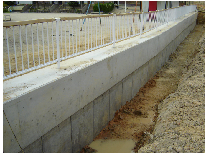
写真-1 擁壁完了全景 (本工事:埋戻後完成)
