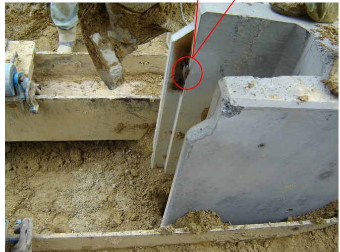
写真-2 目地間隔保持用ピース
