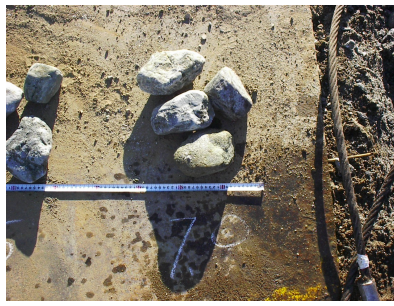
写真-3 玉石の排出状況
