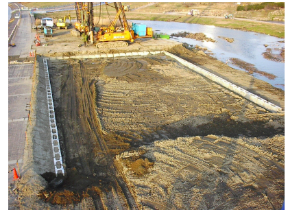
写真-4 施工完了時の状況
