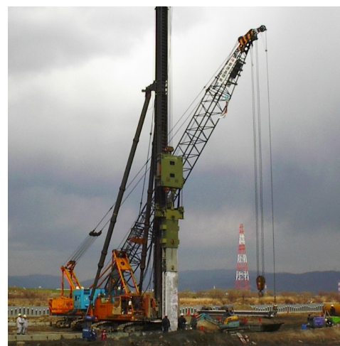
写真-1 H型PC杭の施工状況
