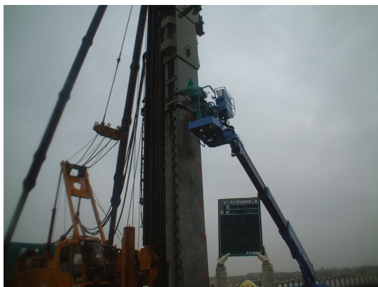
(3) オーガースクリューの取付け
