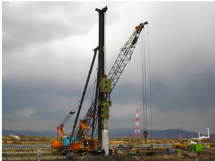
写真-2 施工状況の全景
