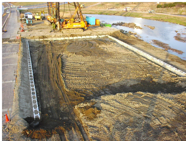
写真-4 施工完了
