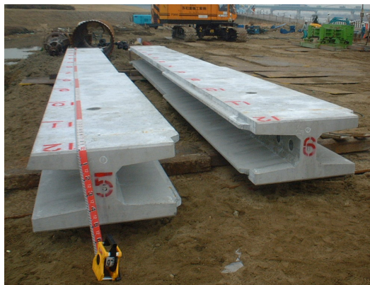
(1) H型PC杭の搬入確認
