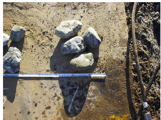
写真-6 玉石の排出状況 (20cm 程度)
