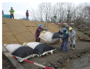
写真-8 設置状況
