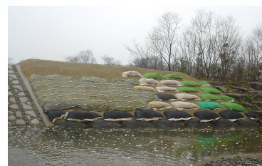
写真-9 設置完了
