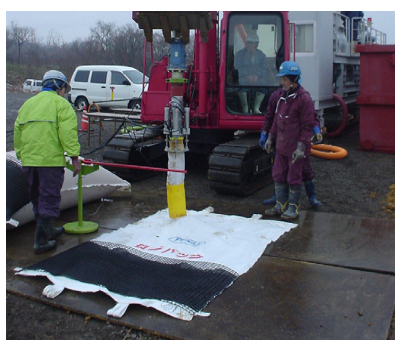
写真-7 充填前状況
