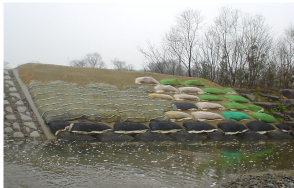
写真-10 積み上げ完了全景
