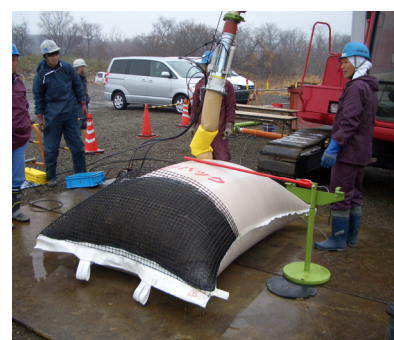
写真-8 充填状況
