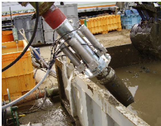
写真-3 エアシリンダー式充填装置
