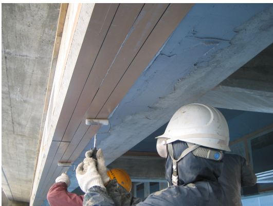
写真-3 炭素繊維プレート貼付状況
