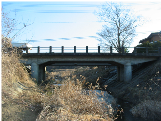
写真-1 施工前(全景)
