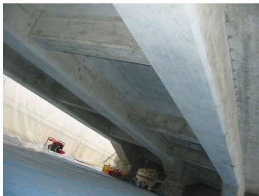
写真-2 施工前(主桁下面)
