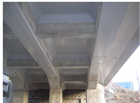
写真-4 主桁補強完了状況
