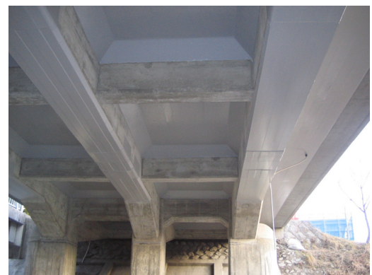
写真-12 主桁補強後状況
