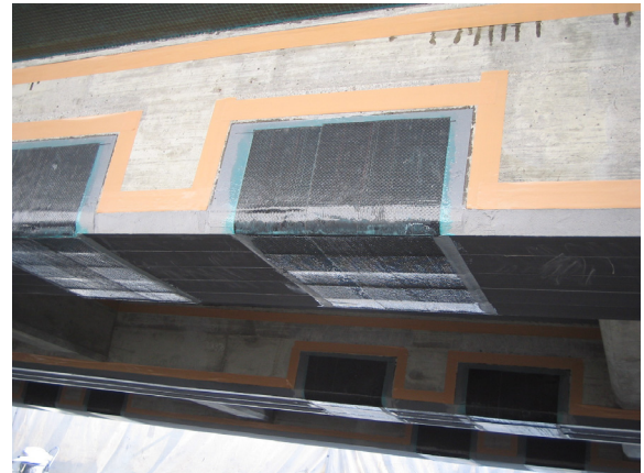
写真-9 継手部補強状況
