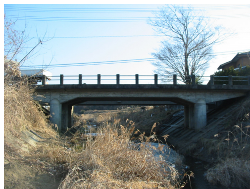
写真-1 施工前状況(全景)
