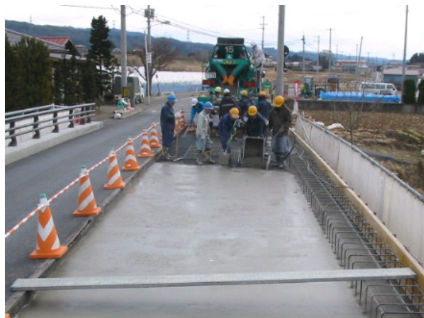
写真-7 打設状況
