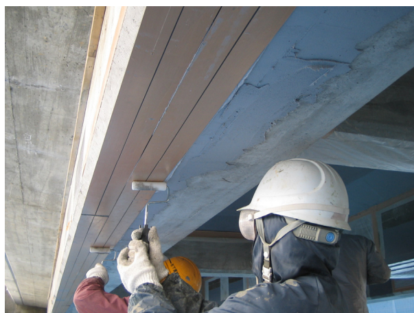
写真-4 炭素繊維プレート貼付状況
