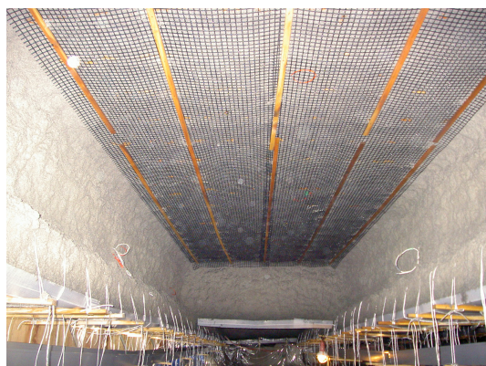
写真-2 脱塩施工状況 (ファイバー式)
