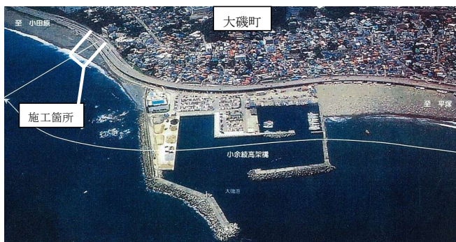
写真-1 全体写真
