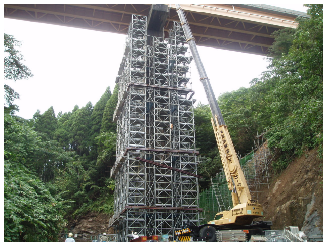
写真-5 鋼桁の仮受け支保工
