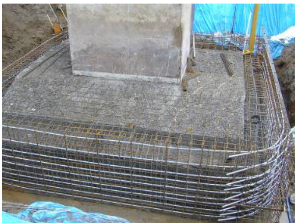
写真-3 フープ方向PC鋼材配置状況
