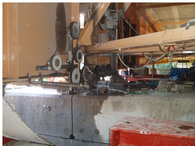
写真-6 ワイヤソーによる梁部取り壊し状況
