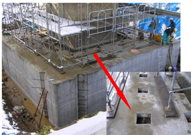
写真-4 鉛直方向PC鋼材配置状況
