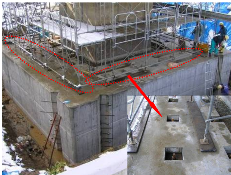
写真-17 鉛直・フープ鋼材配置状況
