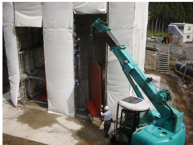
写真-25 鋼板組立状況
