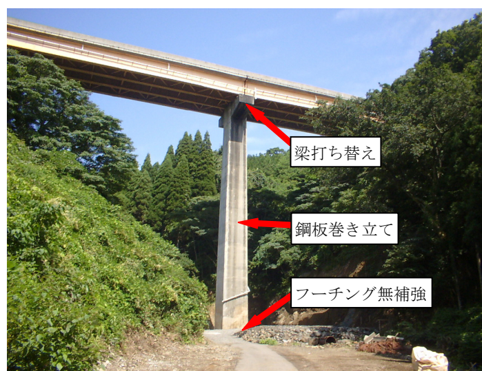
写真-3 B橋着工前状況
