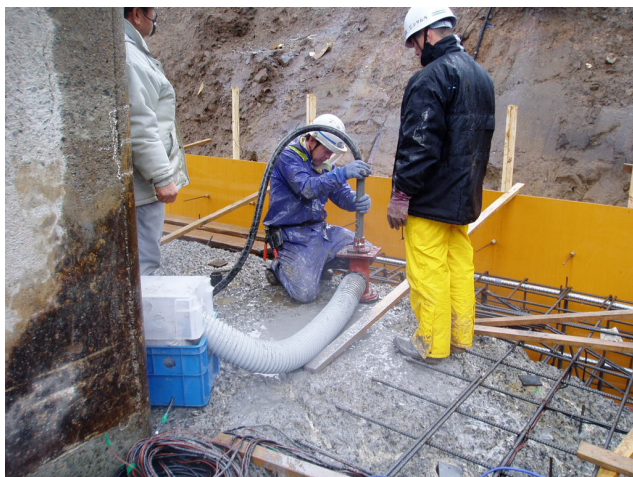
写真-15 サンドブラストによる目荒らし
