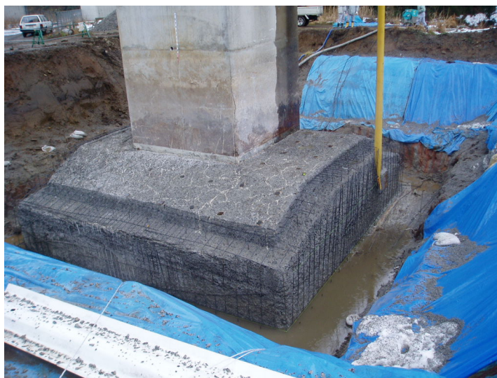
写真-12 A橋のはつり完了状況
