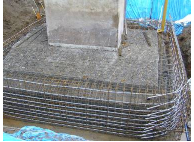
写真-14 補強鉄筋・シース配置状況
