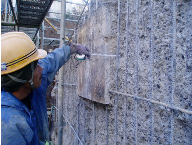
写真-13 鉛直面はつり完了状況
