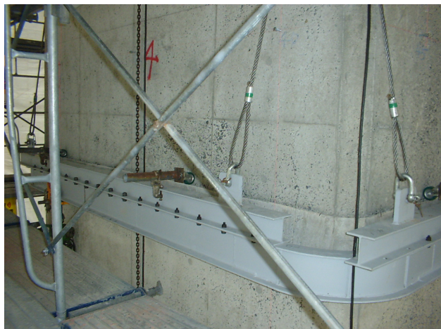
写真-24 鋼板吊り上げ装置
