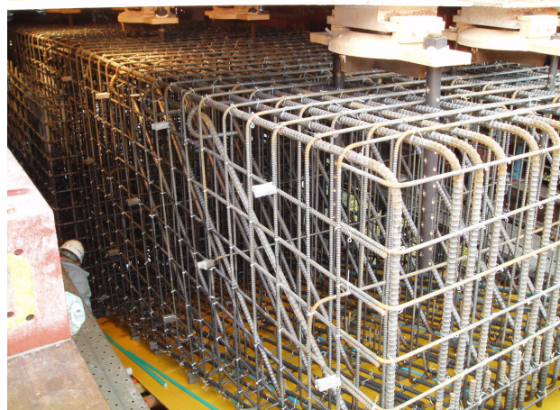
写真-23 鉄筋の配筋状況
