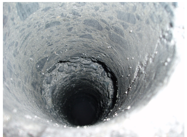
写真-16 定着部目荒らし完了状況
