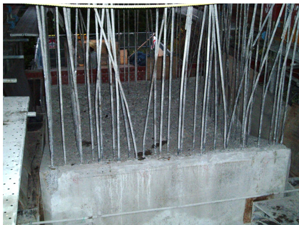
写真-22 取壊し完了状況
