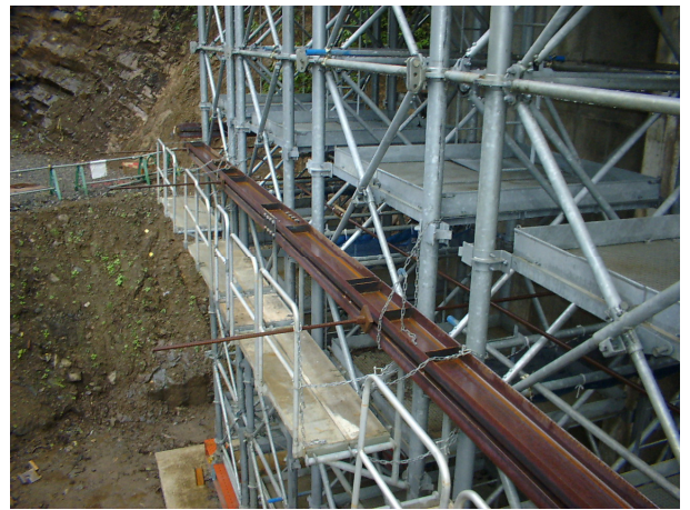
写真-19 水平拘束補強梁
