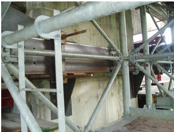
写真-18 水平支持補強梁
