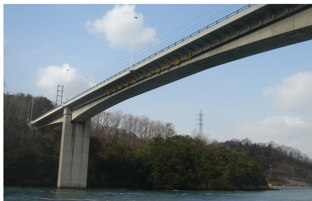
写真-4 工事完了
