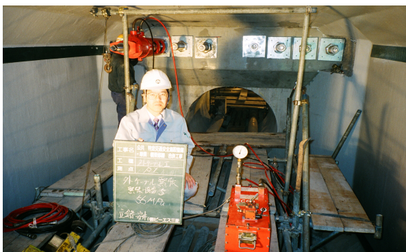
写真-1 外ケーブル緊張状況
