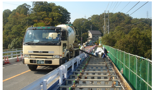
写真-9 コンクリート打設状況
