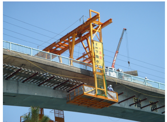
写真-6 作業状況 (その2:側面)
