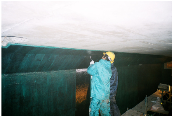
写真-2 炭素繊維シート貼付状況
