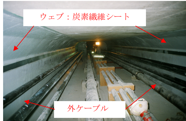
写真-3 主桁補強状況
