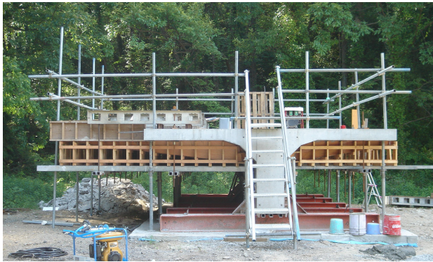
写真-7 試験体状況
