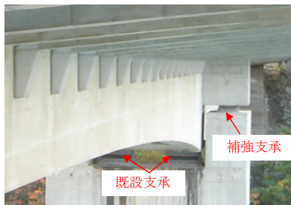
写真-13 P2 橋脚支承配置状況
