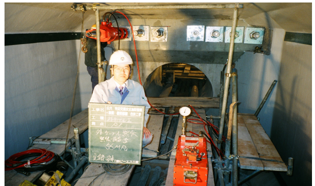
写真-1 外ケーブル緊張状況
