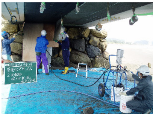
写真—10 導電性塗料吹付状況
