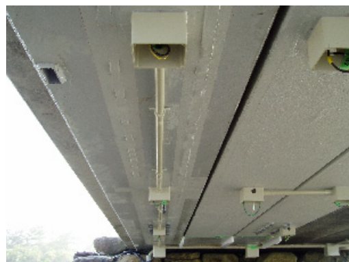
写真-8 陽極被覆完了
