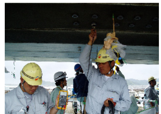
写真-21 測定状況
