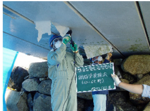
写真—2 樹脂塗装除去状況
