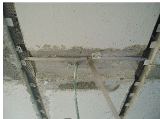
写真-7 陽極接続完了
