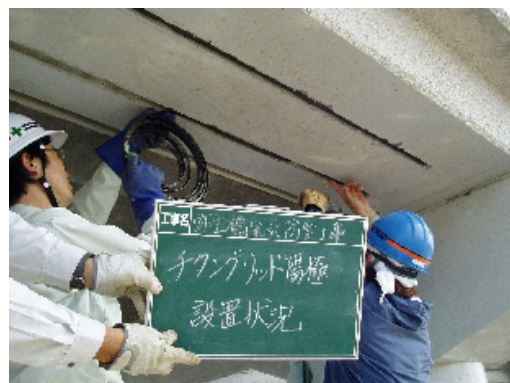
写真-6 チタングリッド陽極設置状況
