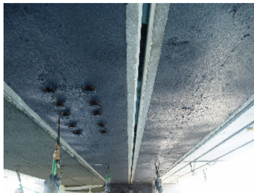
写真—12 導線性塗料吹付完了
