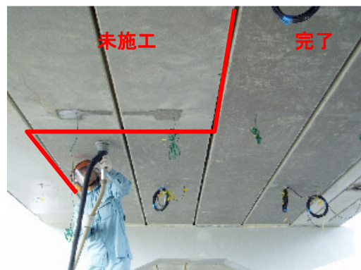
写真—5 施工状況
