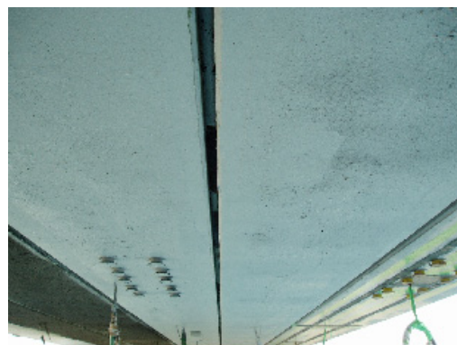
写真—13 トップコート吹付完了
