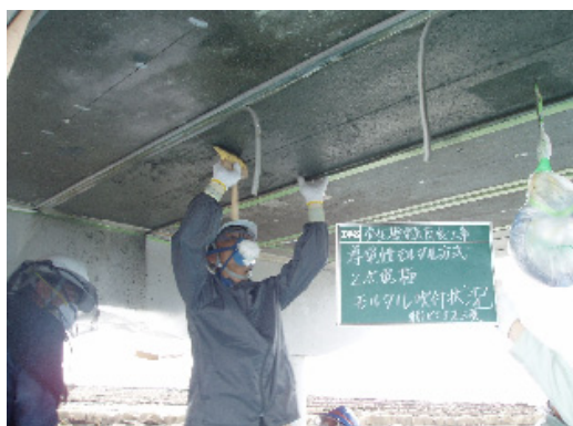
写真—15 擦り込み状況
