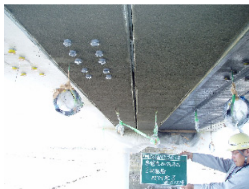
写真—16 導電性モルタル吹付完了
