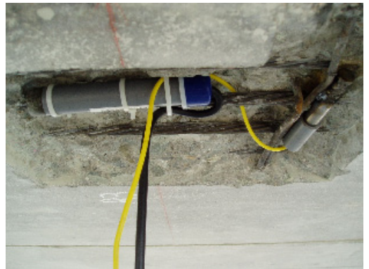
写真—3 照合電極・端子取付
