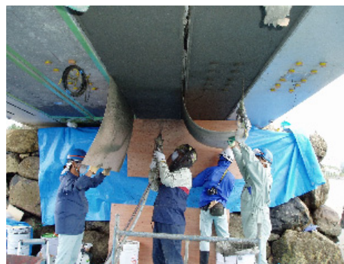
写真—14 導電性モルタル吹付状況
