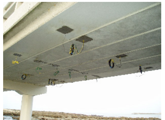
写真—4 断面修復完了
