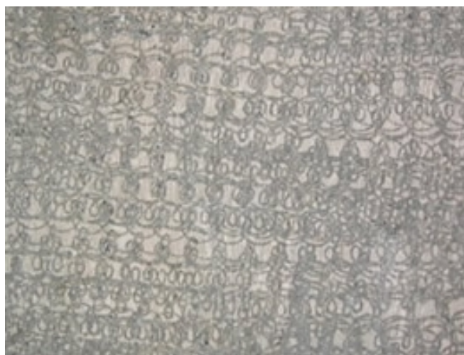
写真-2 超高压洗浄表面 (JSS 工法)
