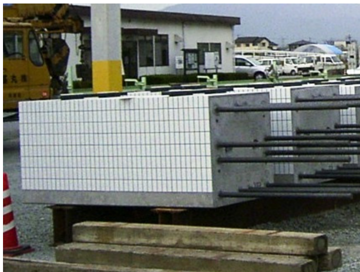
写真-1 タイル先付け柱事例
