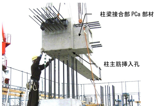
写真-1 部材架設状況
