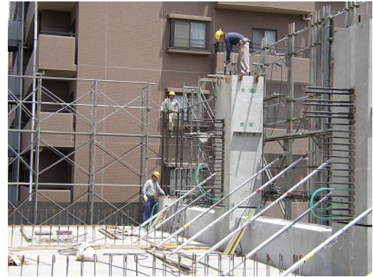
写真-1 柱部材架設・建入れ
