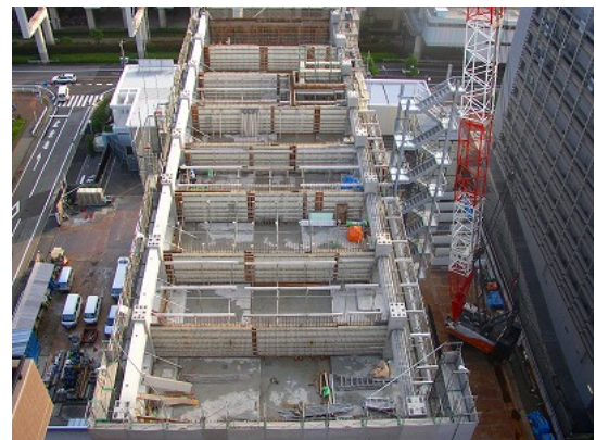
写真-2 架設・建込み状況
