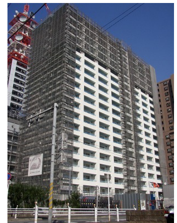
写真-3 せり上げ足場
