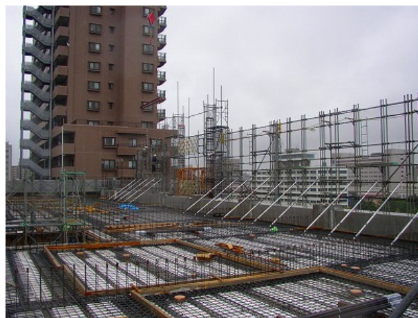
写真-9 スラブ配筋
