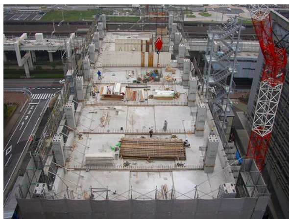
写真-3 柱部材架設(全景)
