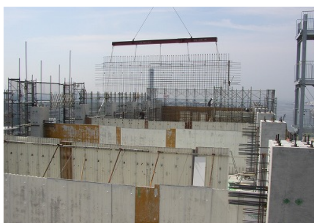
写真-5 耐震壁鉄筋吊り込み
