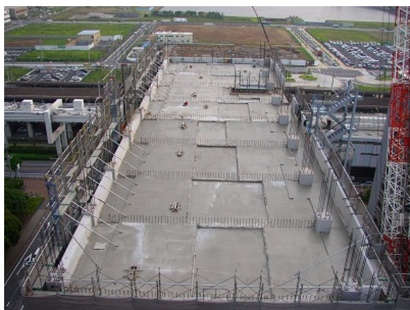
写真-10 コンクリート打設後
