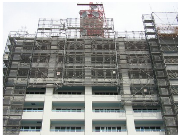
写真-11 足場せり上げ
