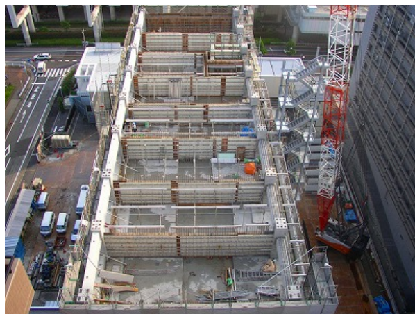
写真-7 架設・建込み状況(全景)
