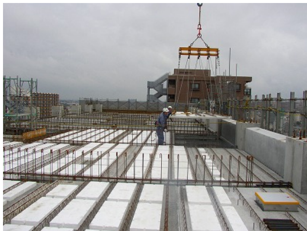
写真-8 床 PCa 板架設
