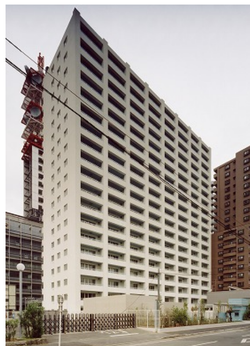
写真-1 建物外観
