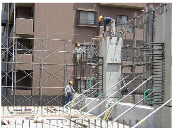
写真-2 柱部材架設・建入れ
