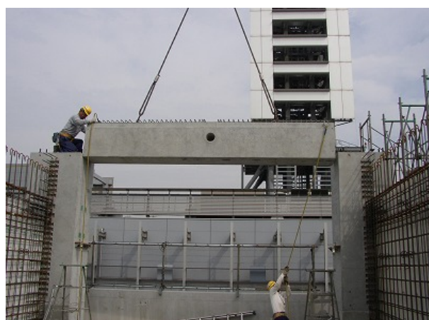
写真-6 梁部材架設
