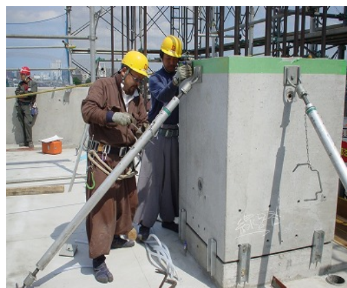
写真-2 柱部材建入れ(分割下部)
