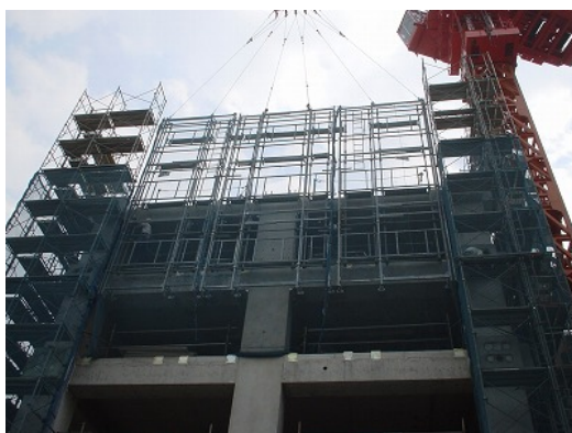
写真-9 足場せり上げ
