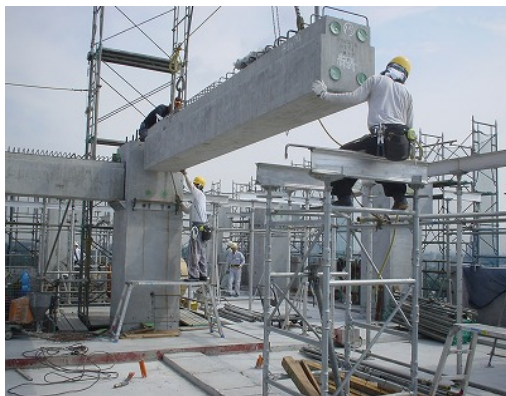
写真-5 梁部材架設
