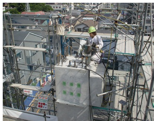
写真-4 柱PC緊張
