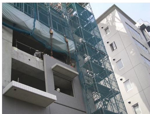
写真-10 カーテンウォール取付
