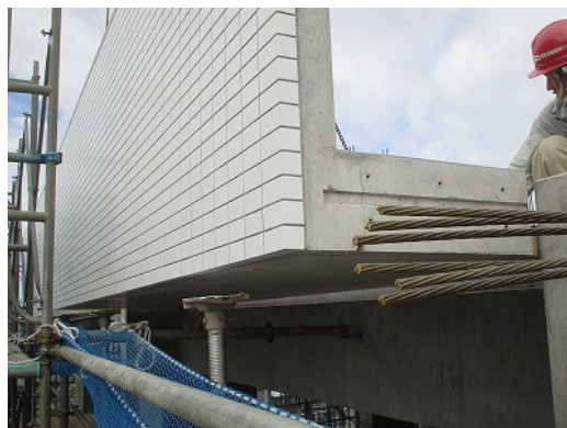
写真-8 バルコニーPCa板架設
