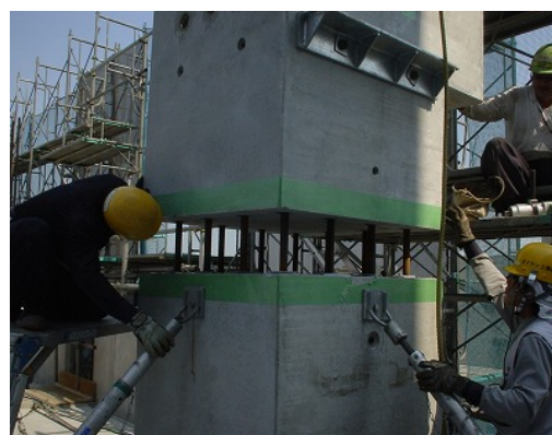
写真-3 柱部材建入れ(分割上部)
